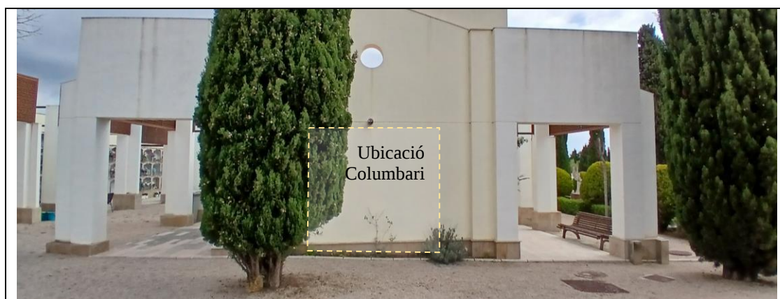
Paret del bloc de nínxols en la que s'adossarà el columbari familiar de paret, tal com es va realitzar amb els altres grups de columbaris a cadascuna de les testeres de blocs de nínxols
