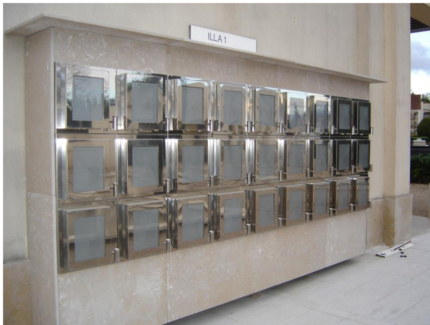
Aspecte del conjunt adossat al bloc de nínxols N1 costat est
