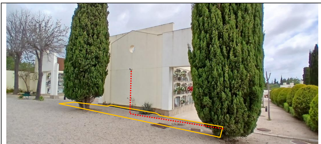
En vermell, traçat de la conducció d'aigües pluvials. Les mesures de paviment (perímetre en taronja) seràn idèntiques a les existents en els altres mòduls. Mesures aproximades de 10,50 x 2,50 m.
