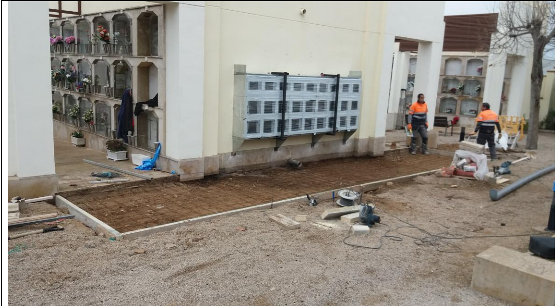
Imatges d'execució en fase paviments, estructura i part de revestiment metàl·lic. Caldrà tenir l'obra totalment protegida amb tanca perimetral que impedeixi l'accés.
