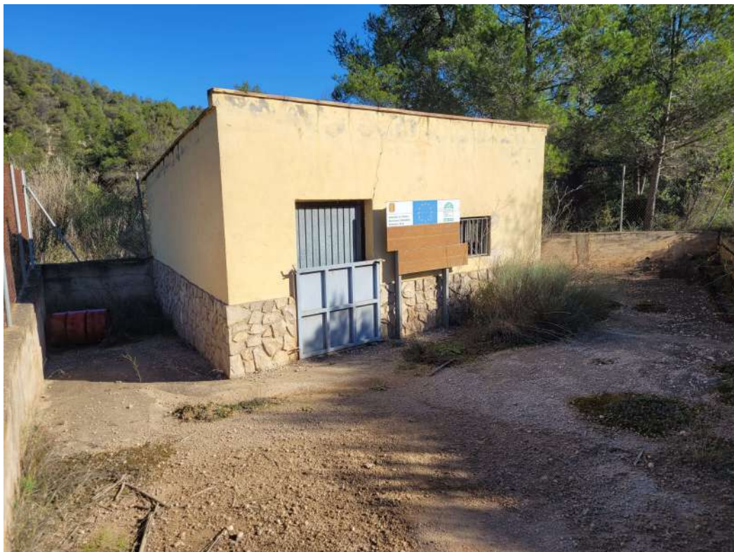
Estació de bombeig de la bassa
