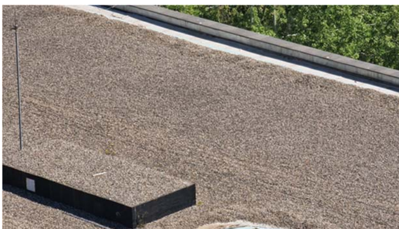
Imatge 8. Detalls dels elements existents en la coberta
