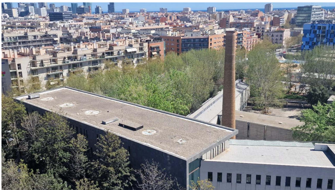
Imatge 6. Vista general de la coberta on s'observen els obstacles que poden generar ombreig
