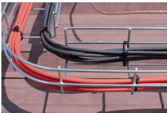
Imatge 9. Separació del cablejat per polaritat
