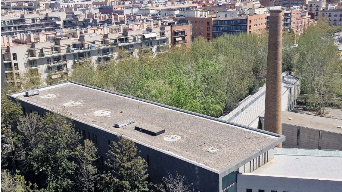
Imatge 1. Vista de la coberta edifici Tànger
