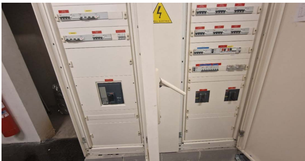
Imatge 16. Quadre general edifici Tànger
