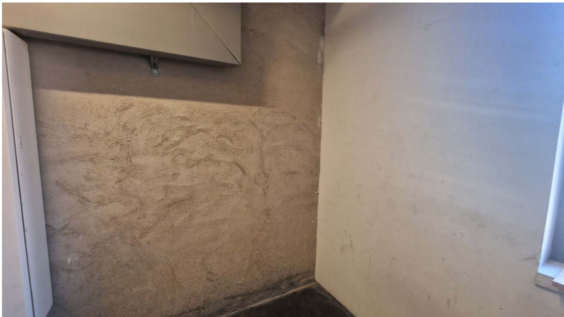
Imatge 4. Localització on anirà l'inversor i les caixes de protecció
