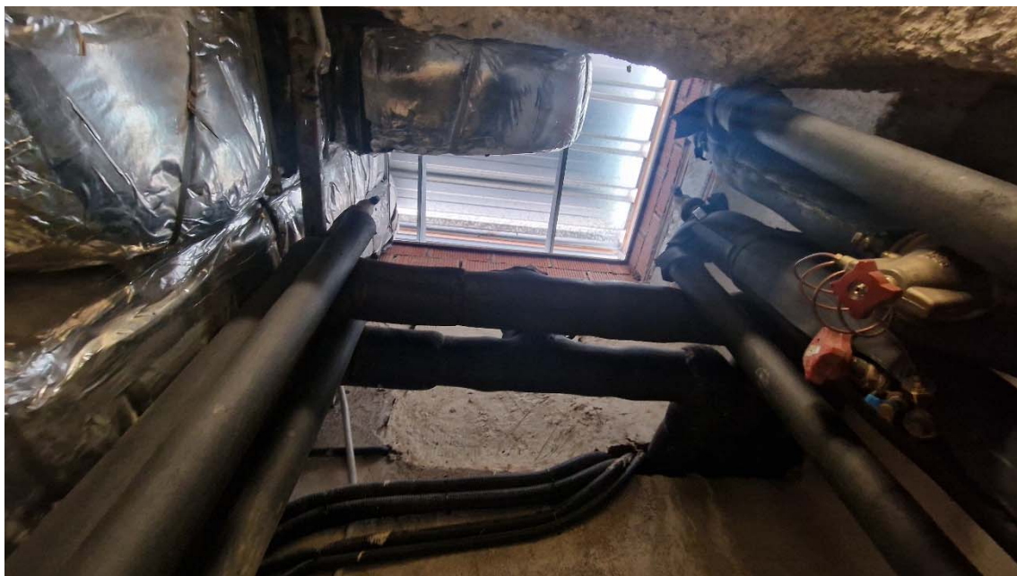
Imatge 6. Imatge de galeria existent pel pas del cablejat
