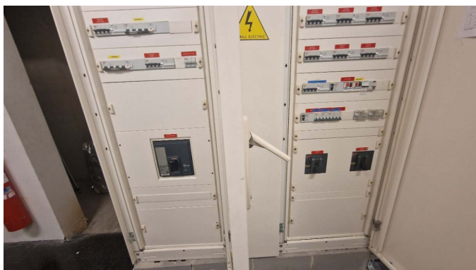
Imatge 2. Quadre general edifici Tànger
