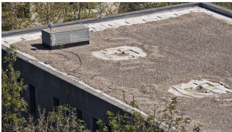
Imatge 9. Detalls dels elements existents en la coberta
