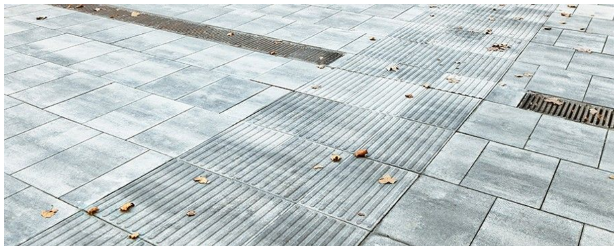
Figura 7. Paviment podotàctil en paviments especials de llabord
