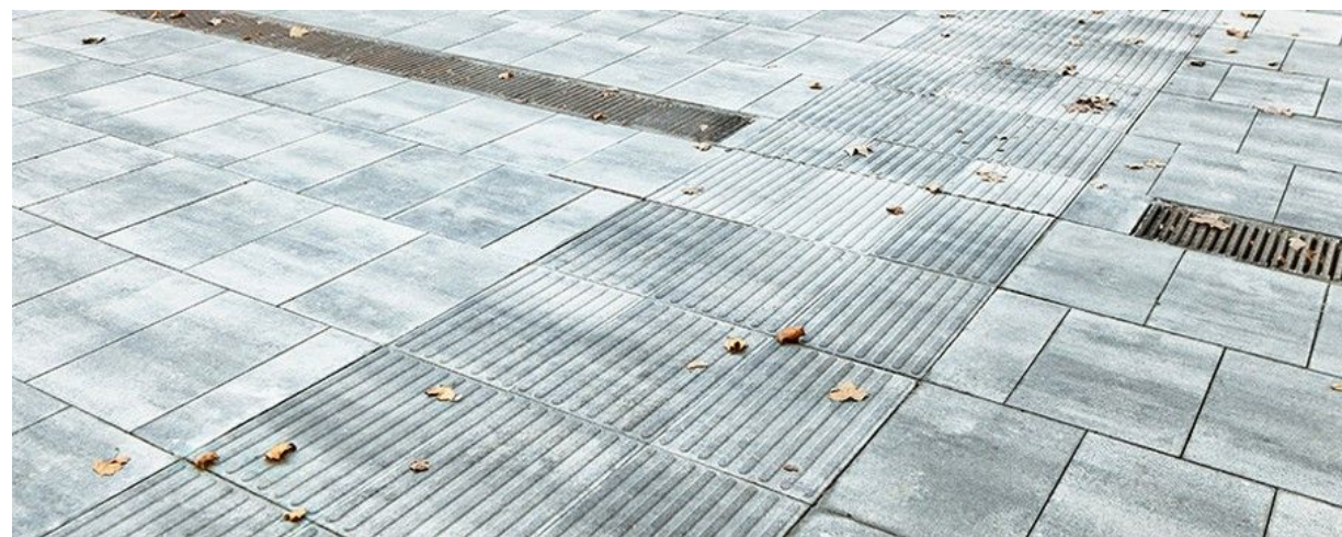
Figura 15. Paviment podotàcil en paviments especials de llabord
