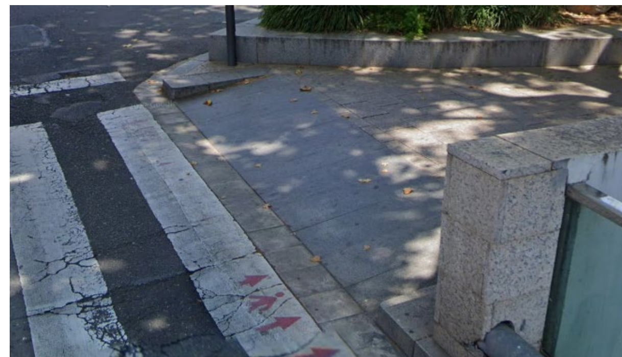
Figura 16. Exemple de gual prefabricat amb pedra granítica a la Plaça del Nen de les Oques de Reus
