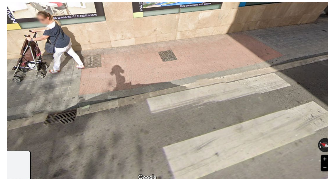
Figura 4. Incorrecta aplicació de gual en carrers amb amplada inferior a 1,80 m. Plaça de Joan Rebull.
