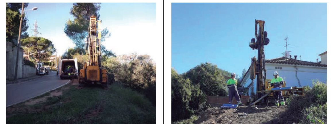
Sonda Tecoinsa TP-50 emplaçada als sondeigs S-1 i S-2
