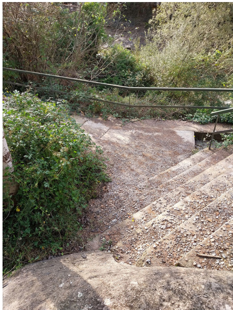
F6 final canal coberta
