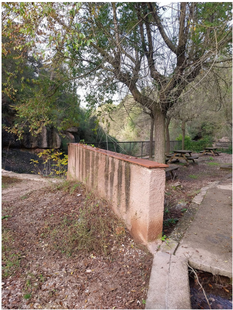
F17 mur de formigó armat
