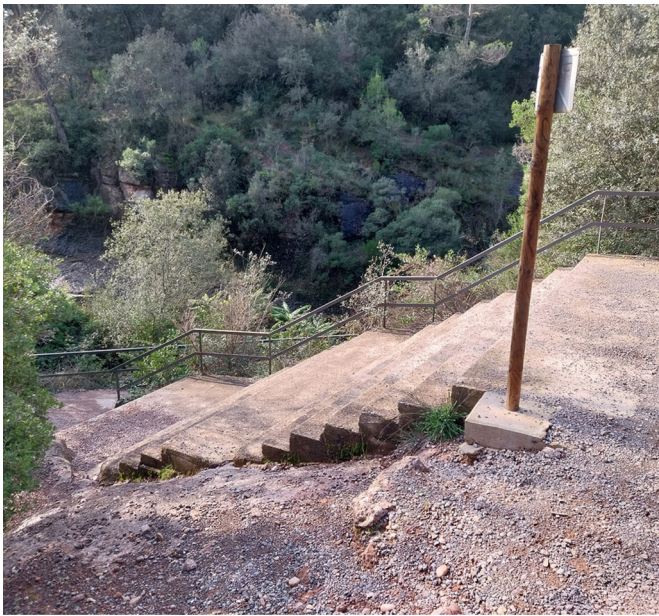
F2 contacte entre escala de formigó i roca
