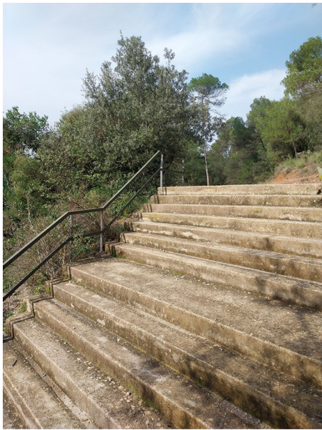
F4 escala de formigó i barana metàl·lica
