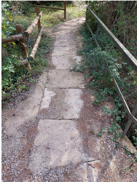
F24 detall llosetes de formigó de cobrició canal
