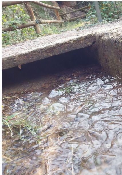
F21 detall cobrició canal de formigó
