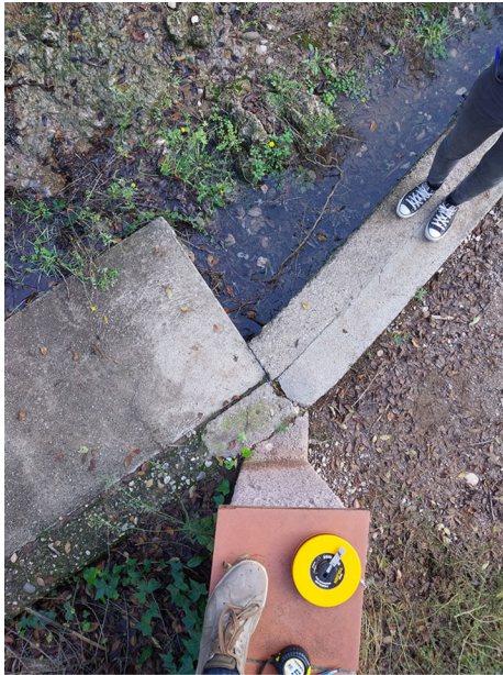
F26 trobada canal coberta-canal descoberta
