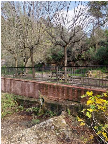
F19 murs de contenció de plataforma i col·lector
