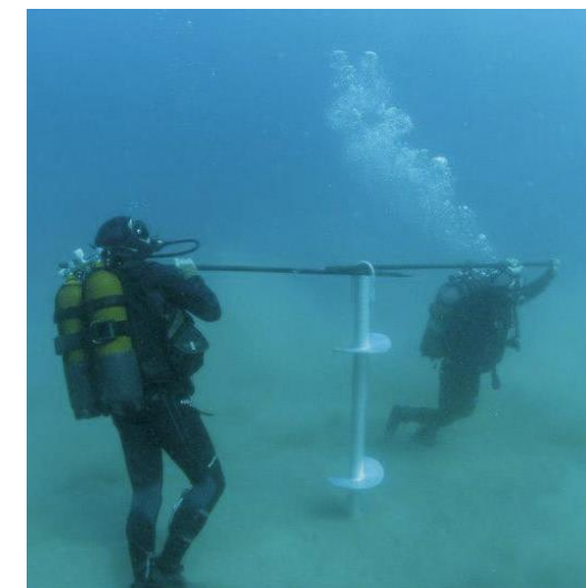
Figura 1. Ancoraje helicoidal
