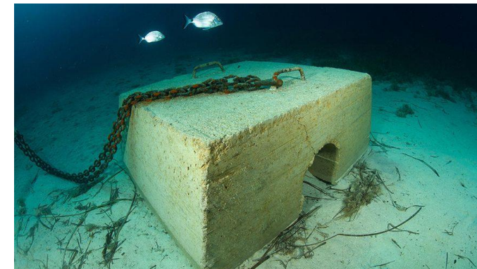
Figura 7. Muerto de hormigón convencional
