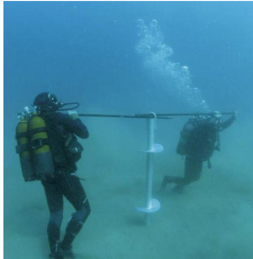
Figura 9. Ancoraje helicoidal
