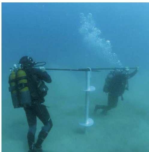
Figura 13. Ancoraje helicoidal
