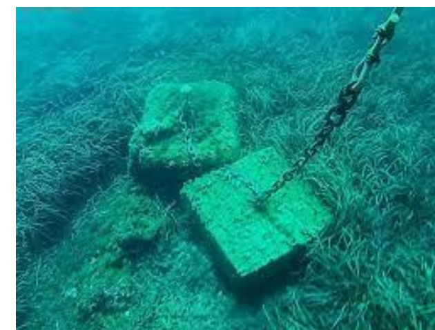
Imatge 3 Mort de formigó
