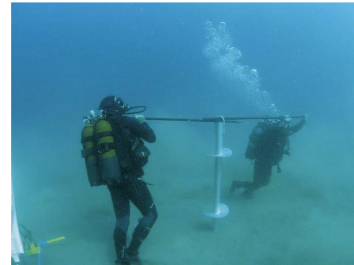
Imatge 5 Instal·lació d'ancoratges helicoidals
