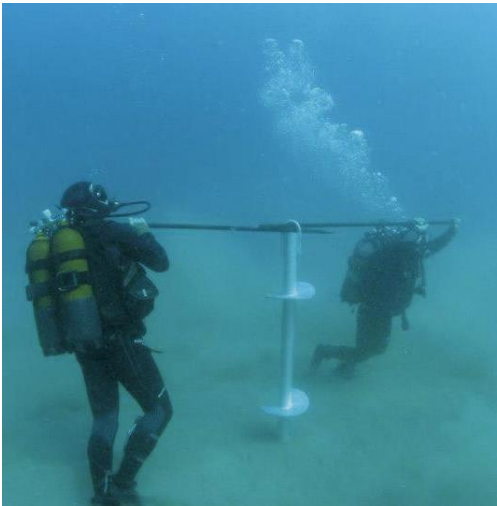
Figura 3. Ancoraje helicoidal
