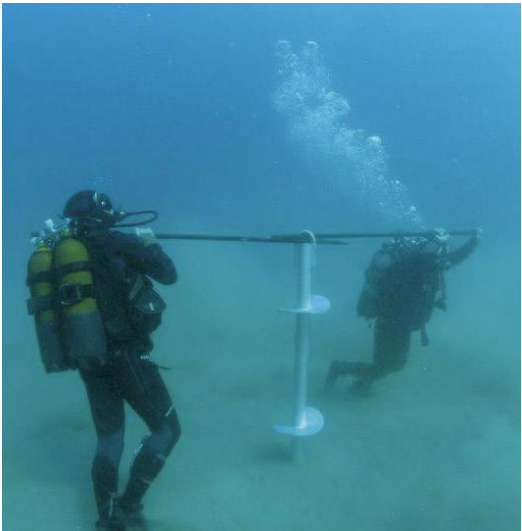
Figura 15. Ancoraje helicoidal
