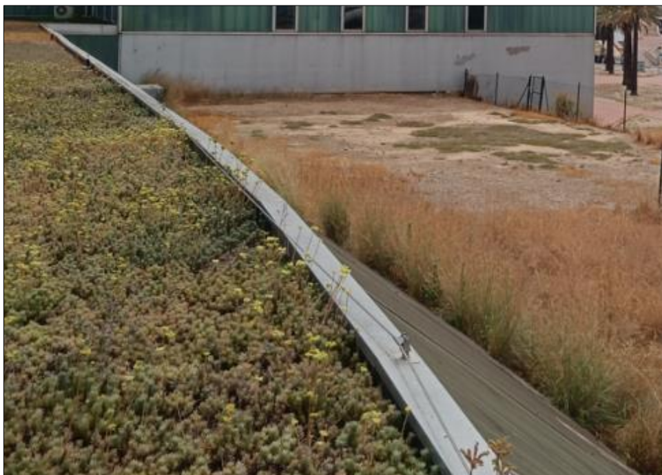
Detall existent de línies de vida no aprofitables als extrems, sense certificar
