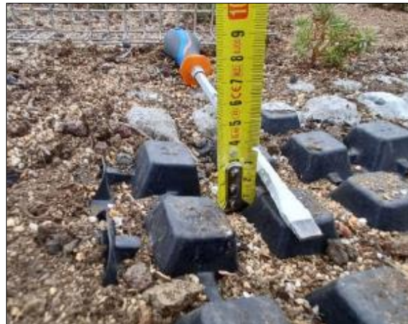
Detall espessor terra de les cobertes
