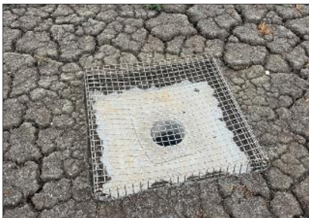
Punts d'evacuació d'aigües pluvials
