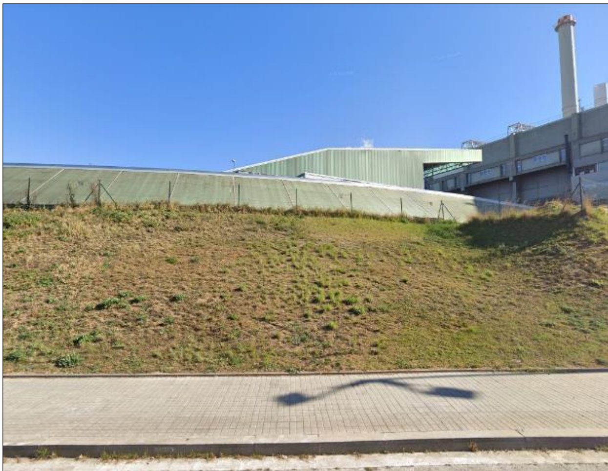
Detall zona de baixada per canalització subterrània i detall tubs
