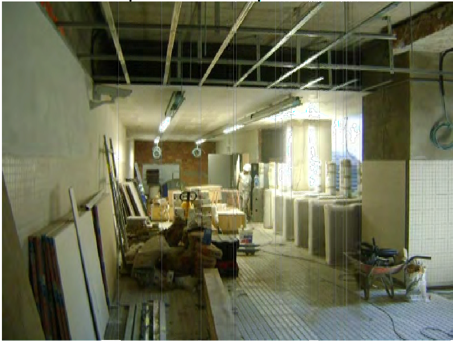
Imatge vestíbul en el transcurs de les obres de remodelació
