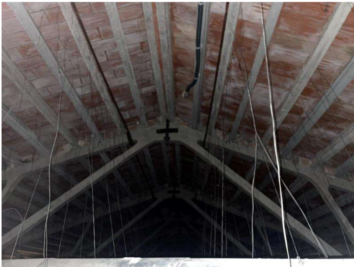
Estructura de la coberta
