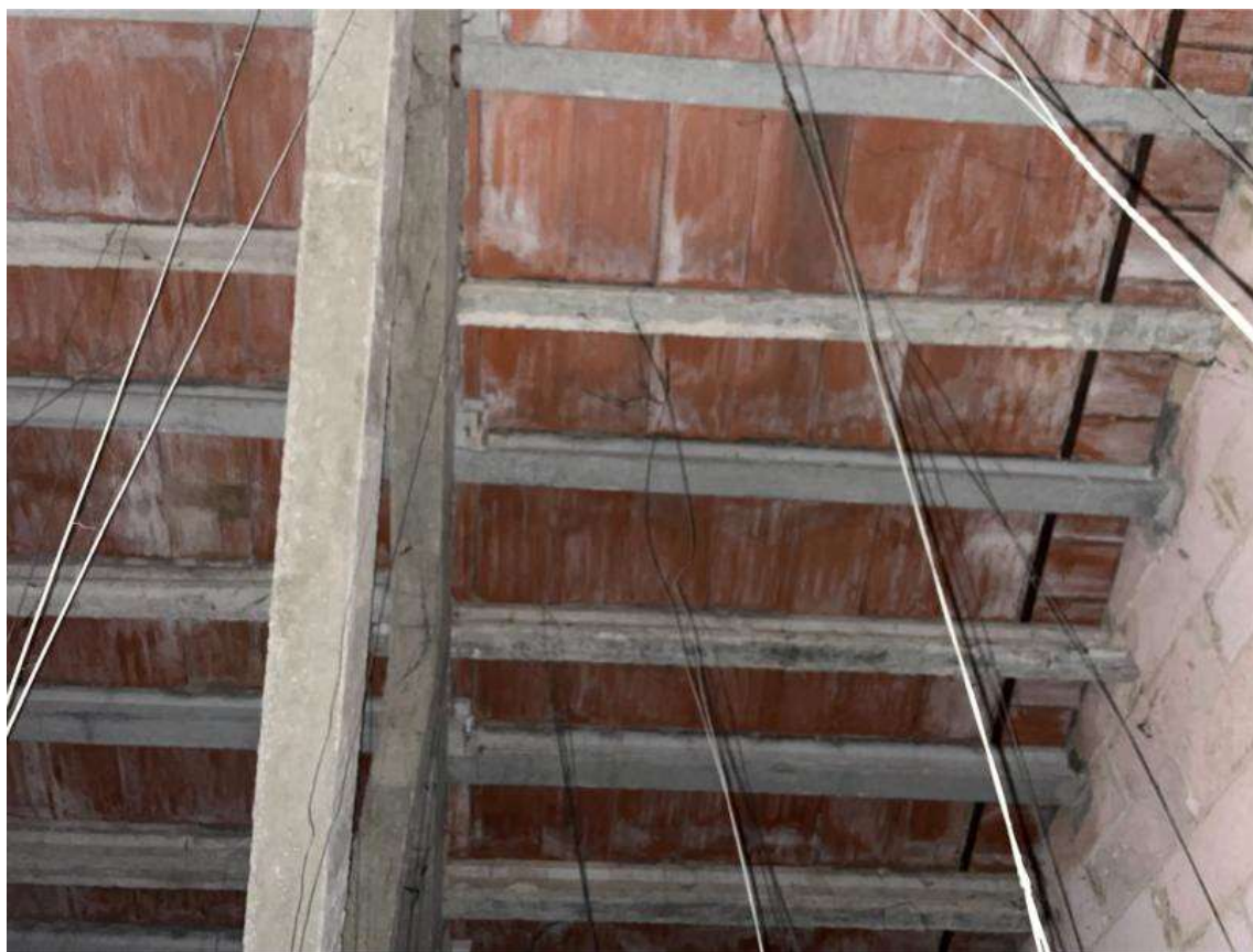
Detall estructura de la coberta
