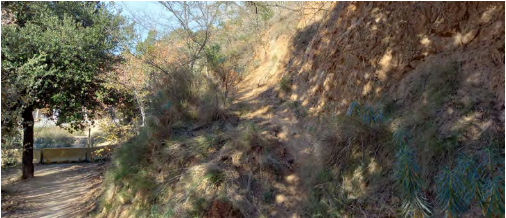
Fotografies del tram d'actuació
