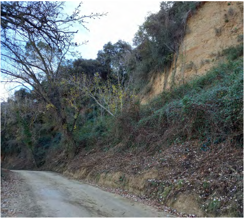
Fotografia del tram d'actuació
