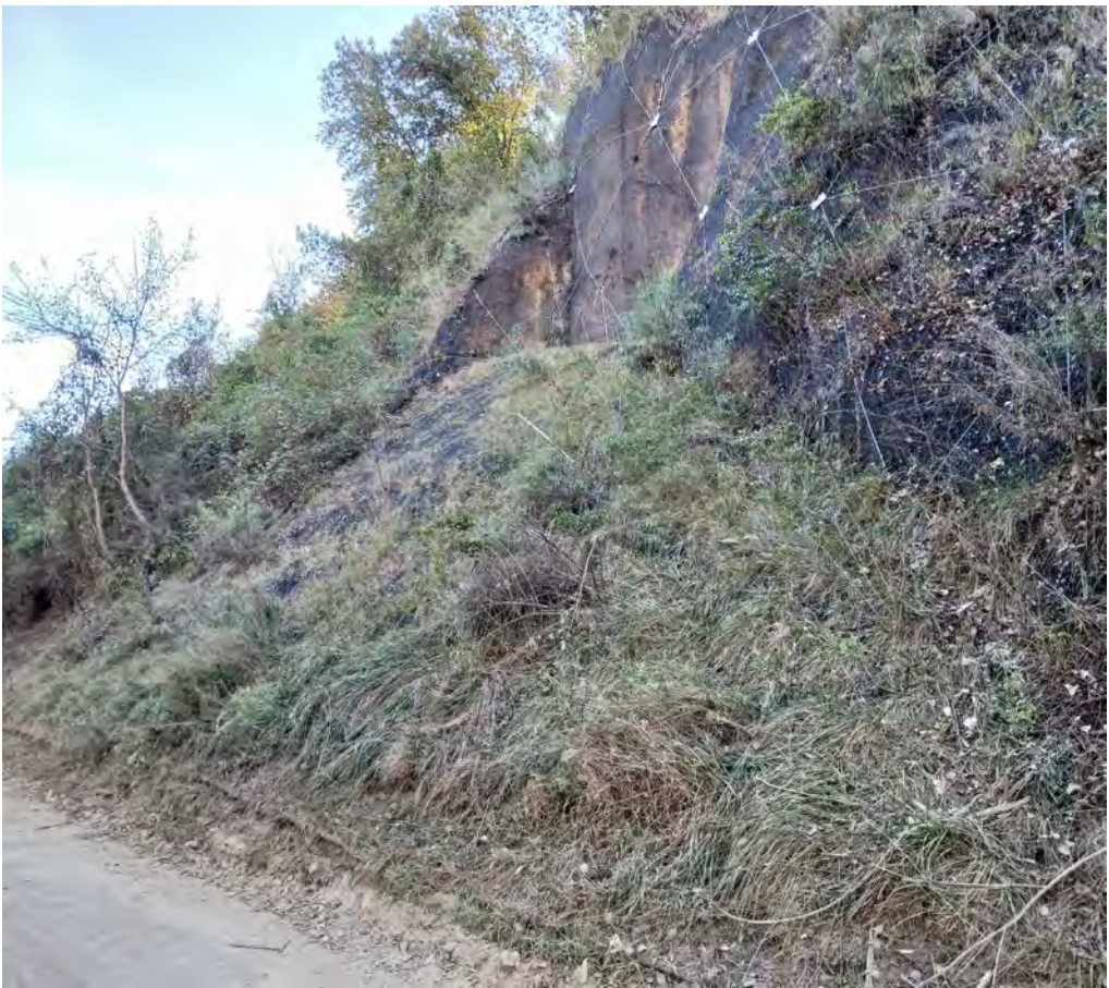
Fotografia del tram d'actuació
