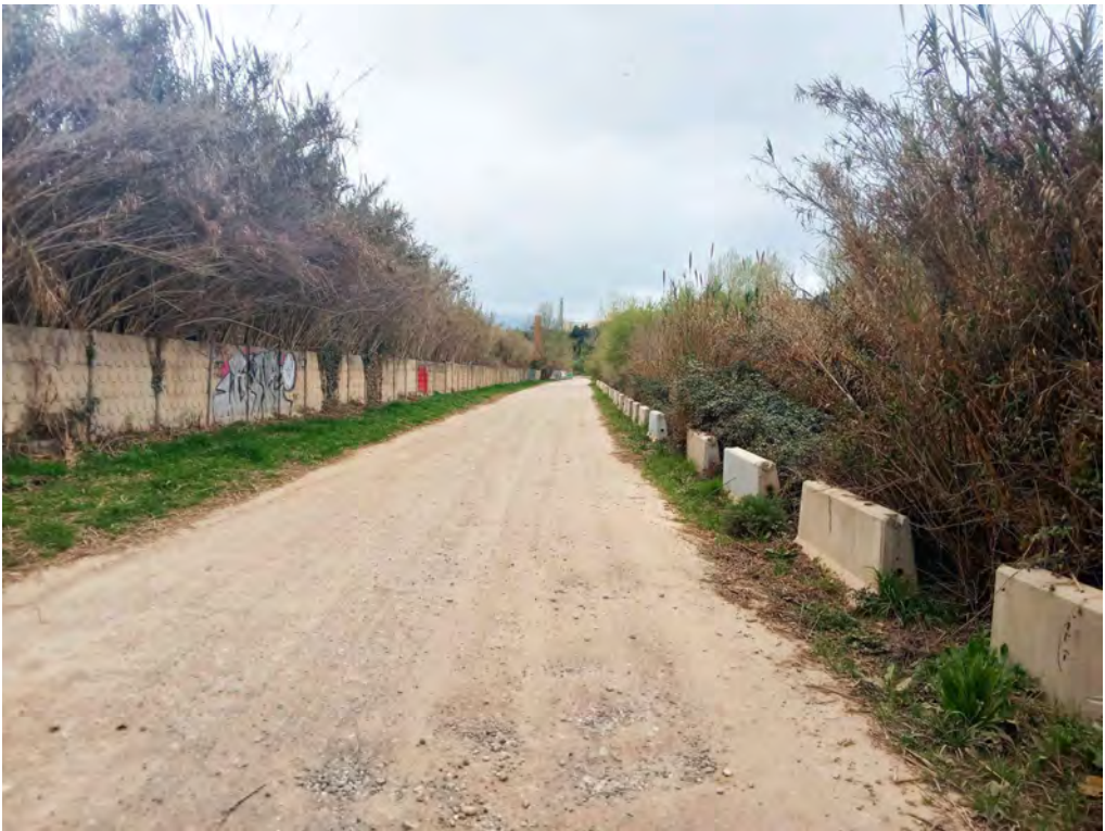
Fotografies del tram d'actuació
