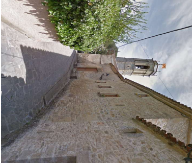
Imatge 11. Fase 2 – Carrer Major.
