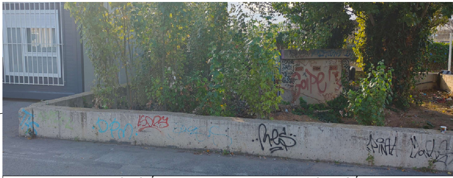
DEMOLICIÓ DE MUR PERIMETRAL DE FORMIGÓ
