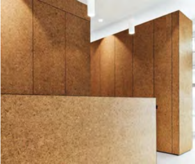
TANCAMENT DE MUR D'OBRA O DE PLADUR REVESTIT AMB APLACATS DE SURO VIST
