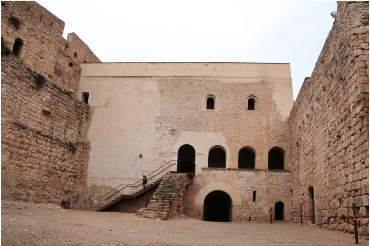
Fotografia 07. Vista general del cos nord del recinte sobirà.
