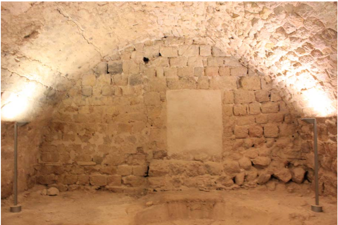
Fotografia 12. Tancament del cantó de llevant de la nau del celler, amb antiga obertura de connexió amb el refetor, cegada.
