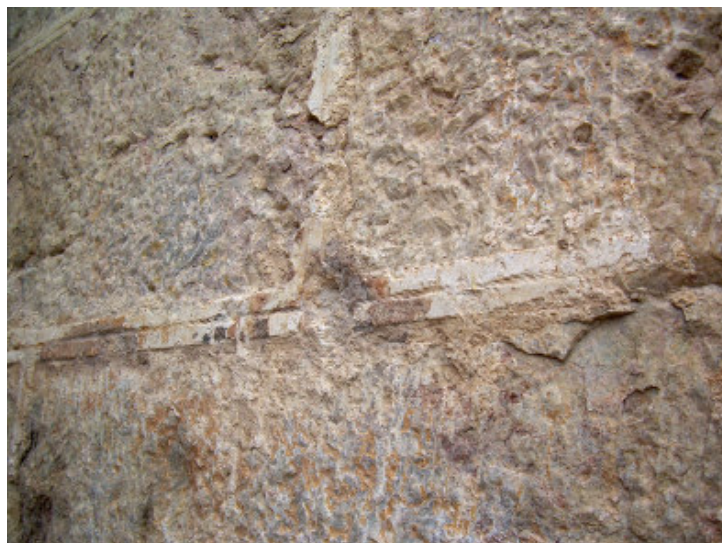
Encintats dels murs del castell, amb la junta horitzontal marcada amb una corda i la vertical amb una eina encisa.
