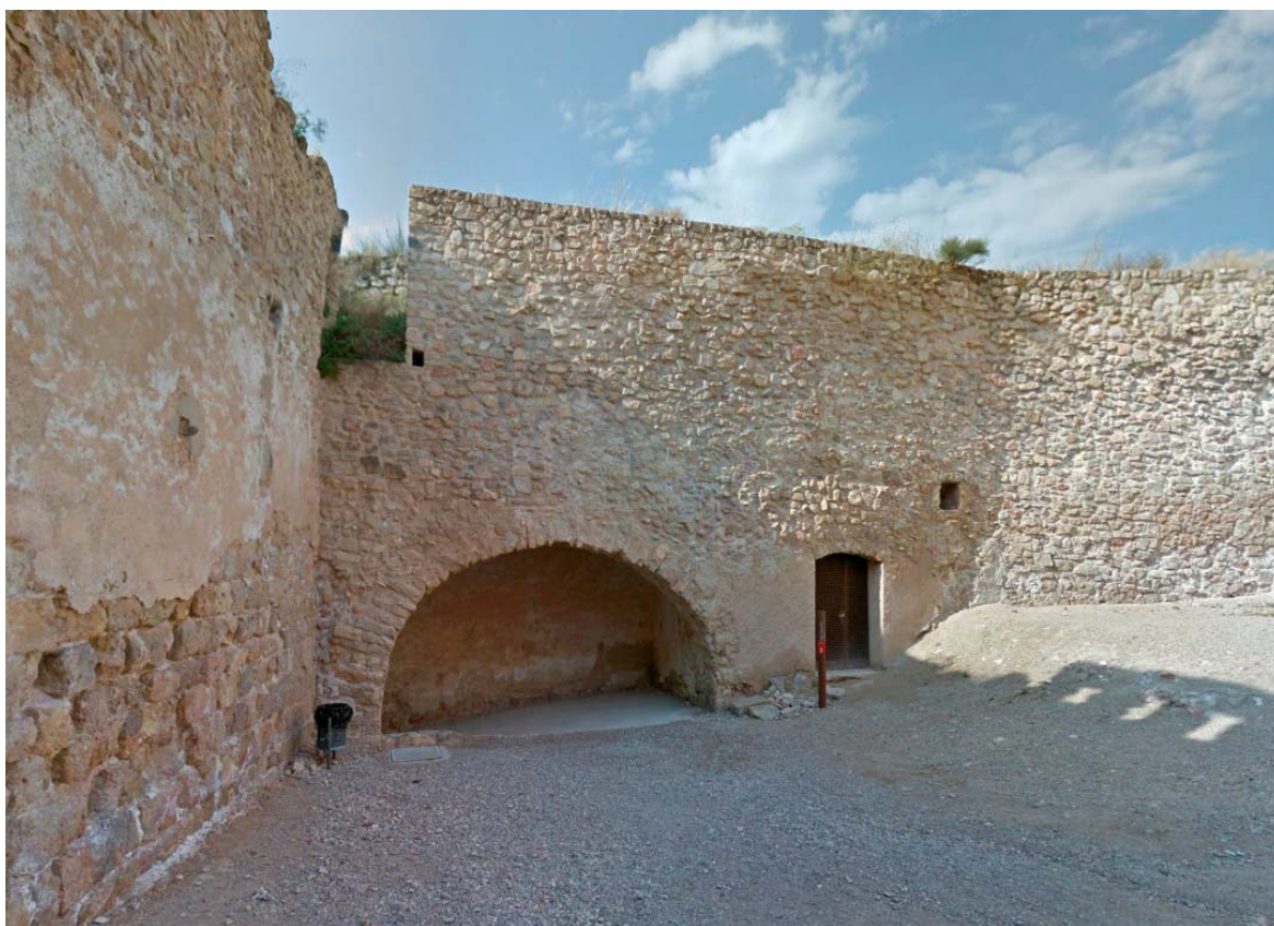
Fotografia 06. Vista de l'arc de mig punt d'accés al corredor des del pati d'armes.
