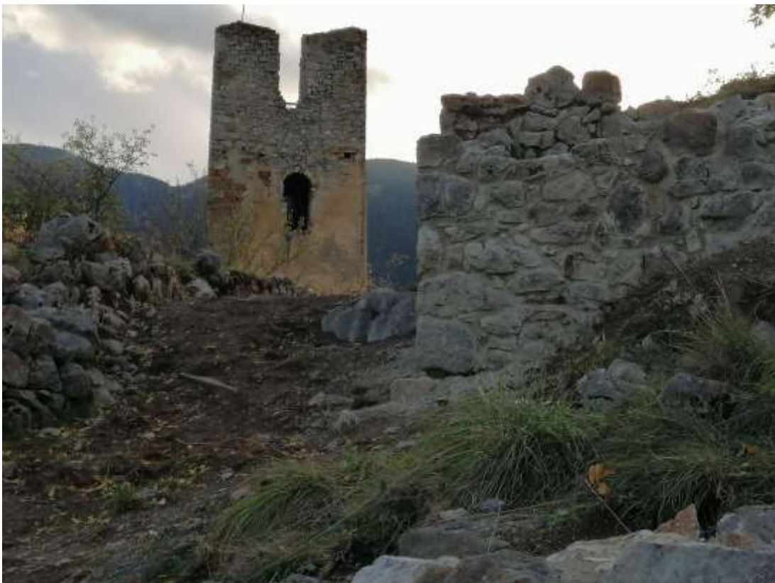
Detall de la part superior del carrer principal longitudinal amb les parets de cases que miren a la placeta
