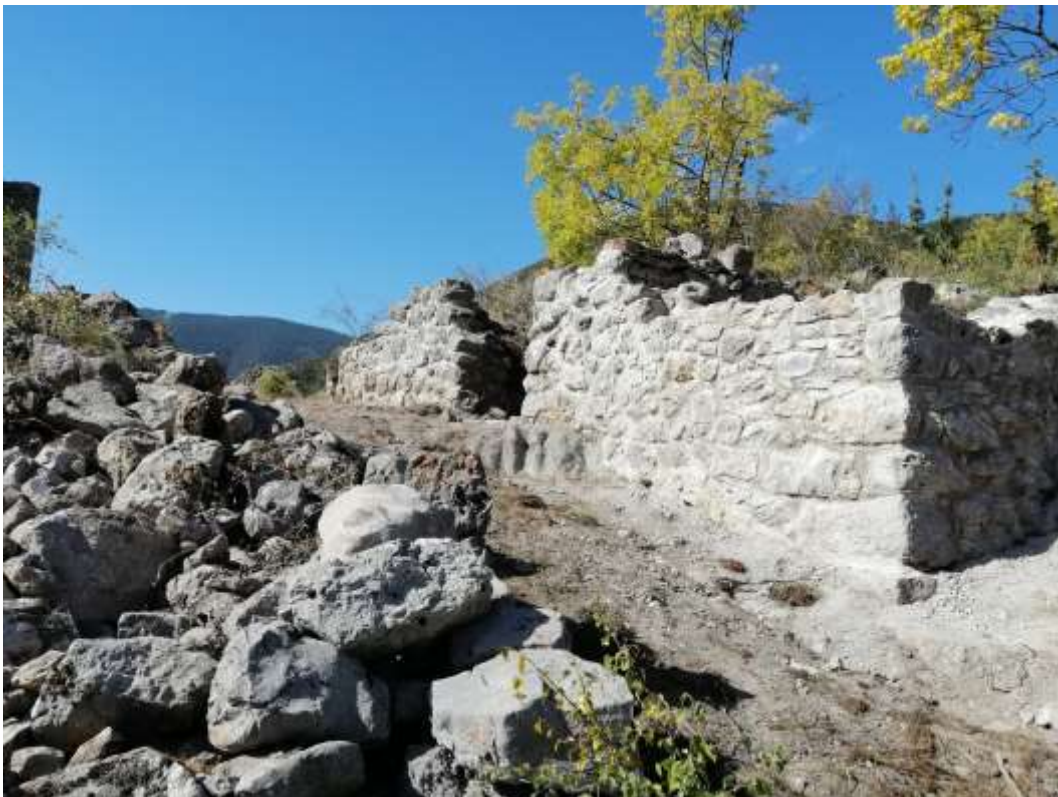
Vista dels paraments de les cases 6 i 7 que miren al carrer longitudinal
