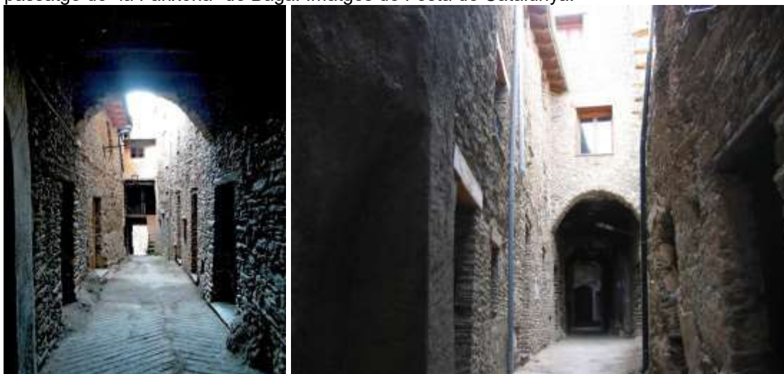
Exemples de passatges coberts a sota de les cases a la vila de Vilamitjana del Cantó. Alt Urgell
