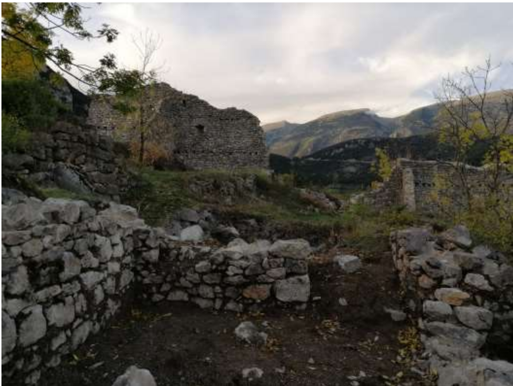
Mur de tancament del callissot amb la porta de comunicació amb la part posterior
