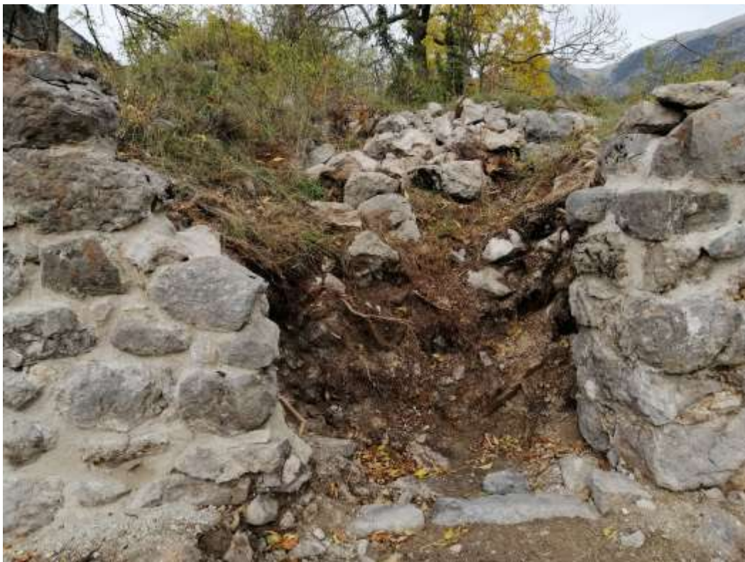
Porta amb mutants i marxapeu de la casa 7 a la part superior del carrer longitudinal transversal
