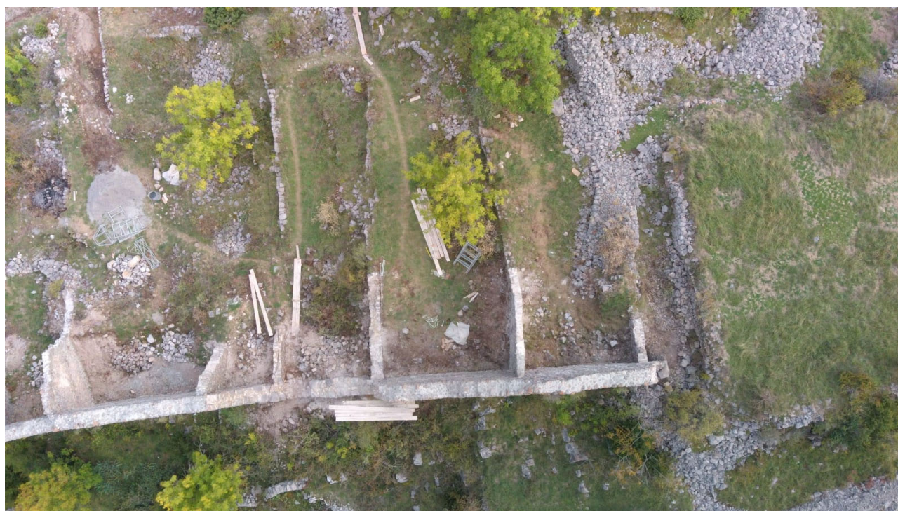
Vista aèria dels treballs de consolidació de la muralla
