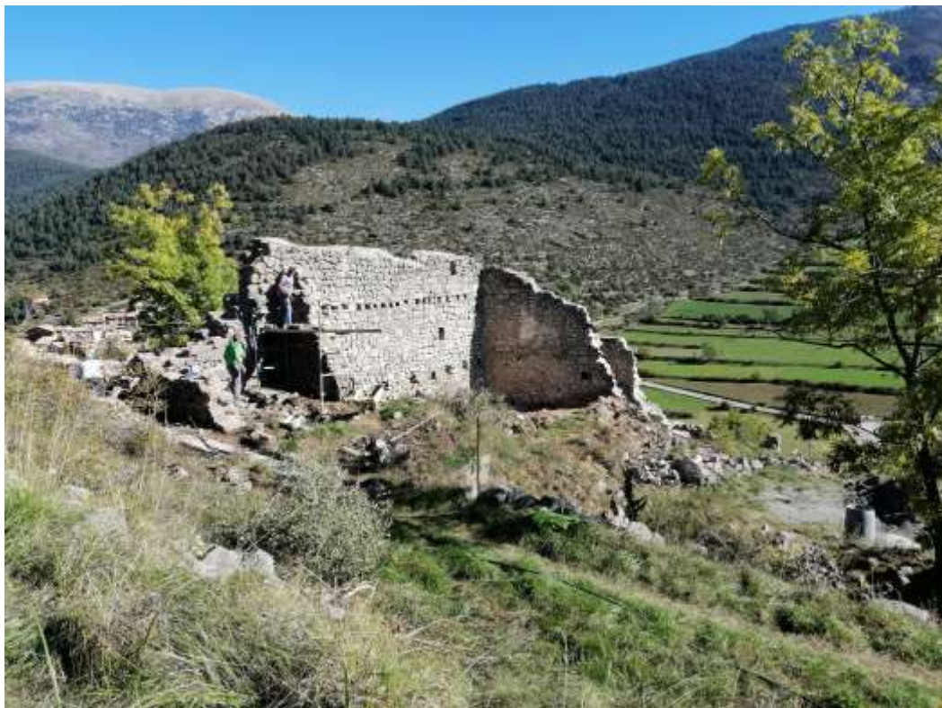
Estat de neteja de la zona de la muralla de tramuntana
