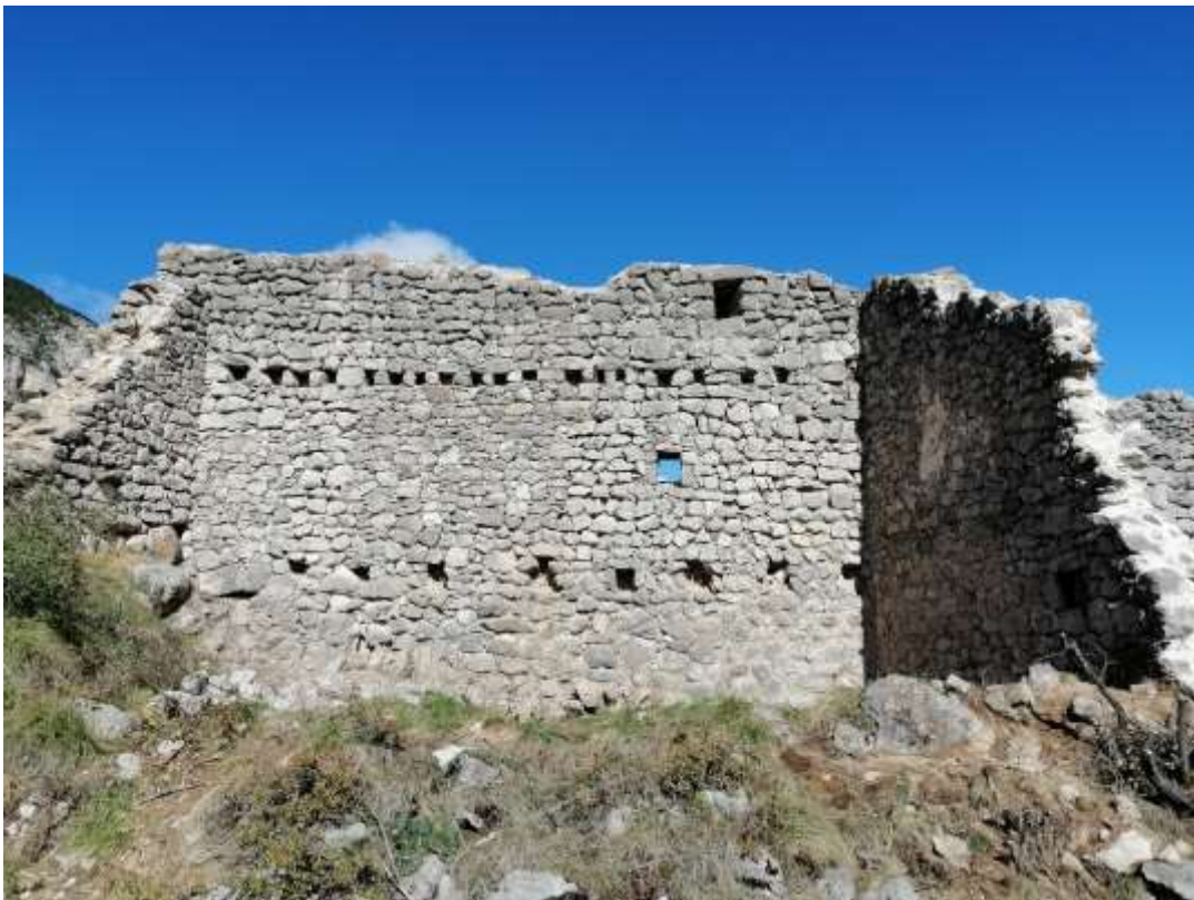
Parament de la muralla al sector de tramuntana en tota la seva alçada
