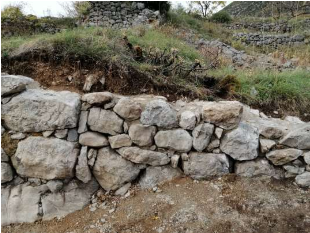
Imatges de la casa 1 amb la cantonada de la casa 2 a la part inferior
