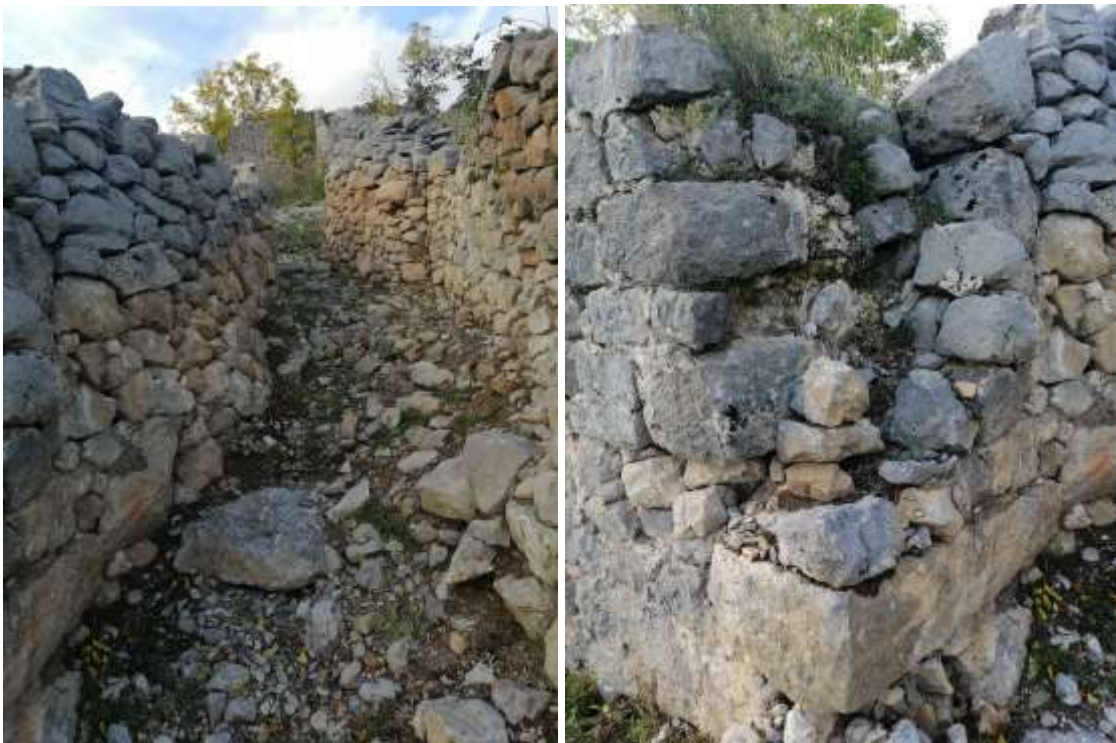
Carrer i muntants de la porta d'accés a la vila vella a la banda sud-est
