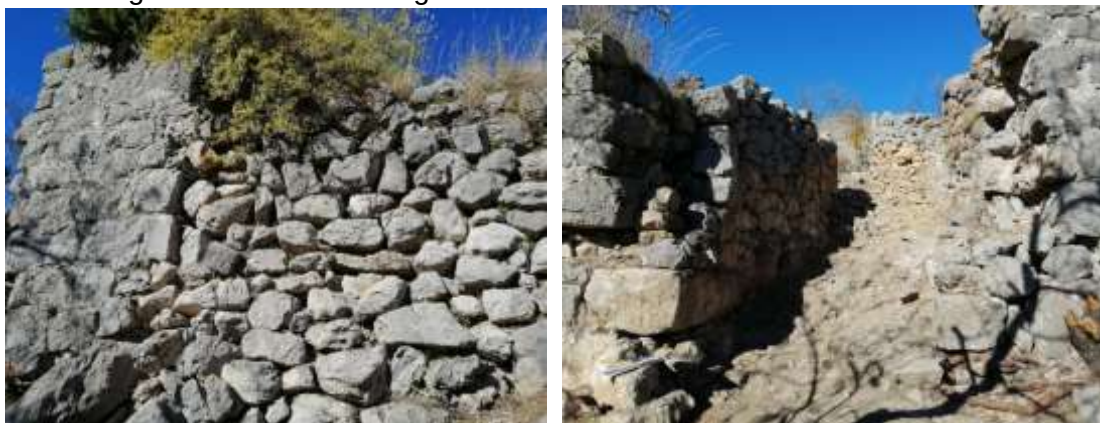
Imatges de la muralla amb la porta. A la dreta el pas de la porta amb els muntants i el carrer. Imatges P. Cascante 2021.
