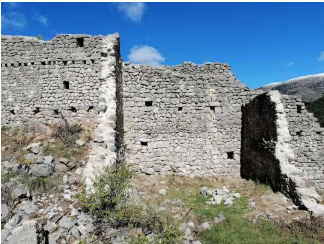
Vista general de les mateixes muralles amb les mitgeres de les cases adossades
