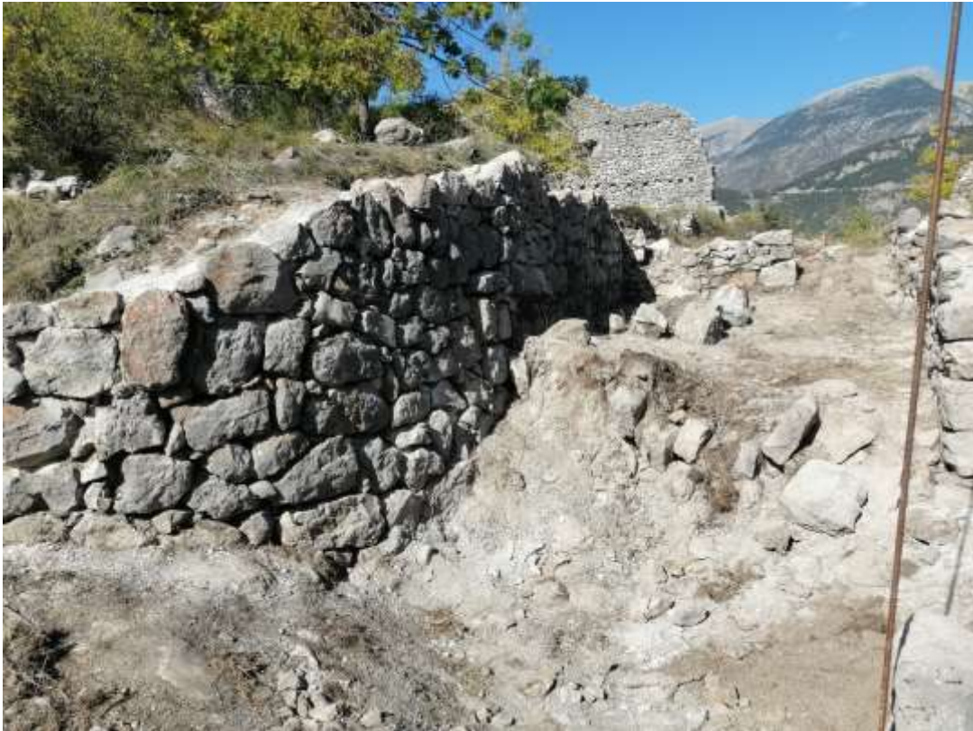
Mur de pedra seca contenció de la terrassa on hi ha la placeta o pati amb el callisot
