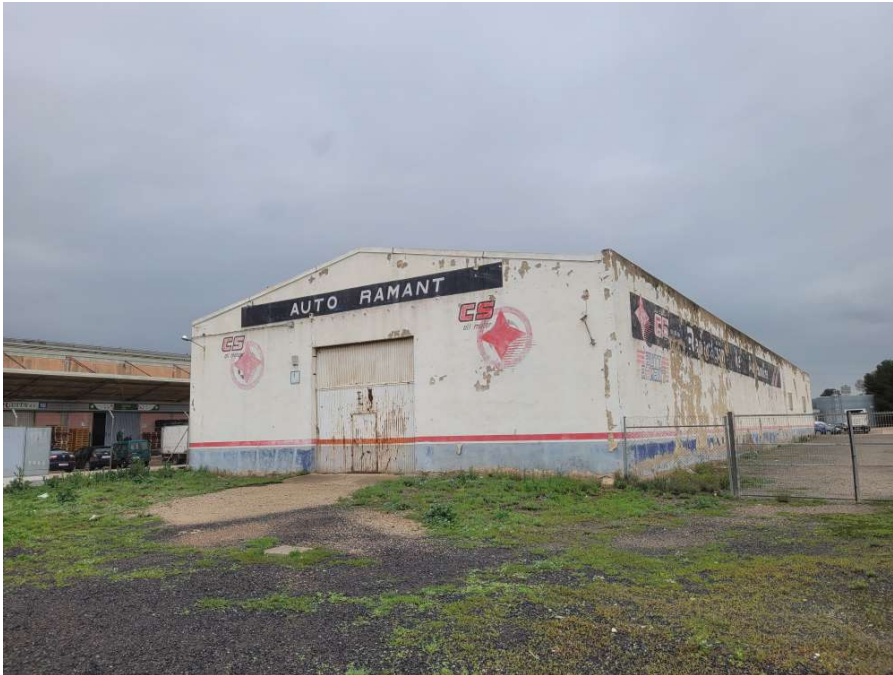
Façana Sud. Nau 5
