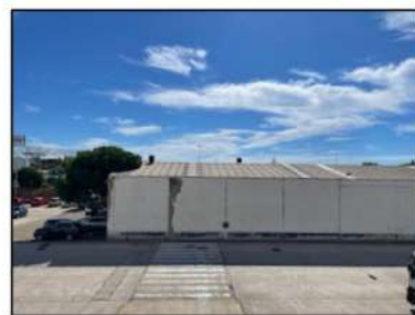
Faç. Lateral 2 - interior Mercat del Camp
