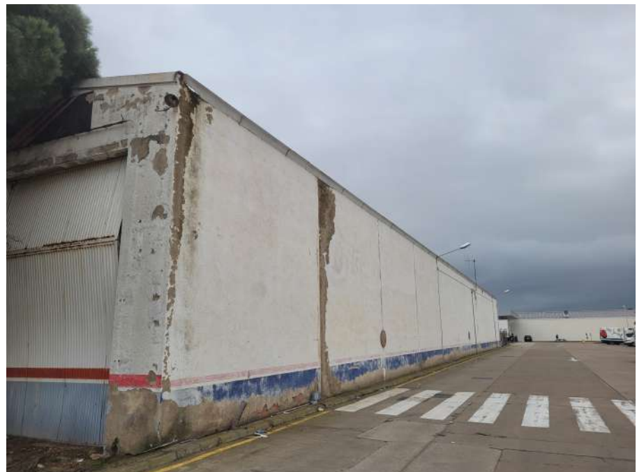
Façana Oest. Interior del Mercat
