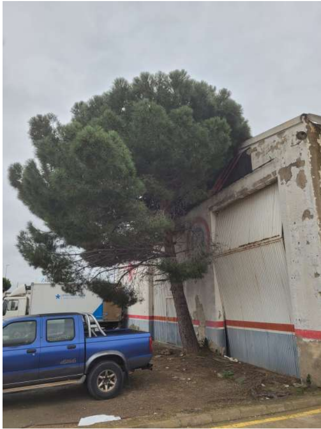
Façana Nord. Nau 3
