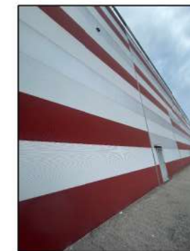
Fotografia Tancament Tipus Panell façana Sandwich de 40 mm PIR Bsd0 amb subestructura, xapa grecada i elements auxiliars Colors: Blanc - Gris - Vermell
