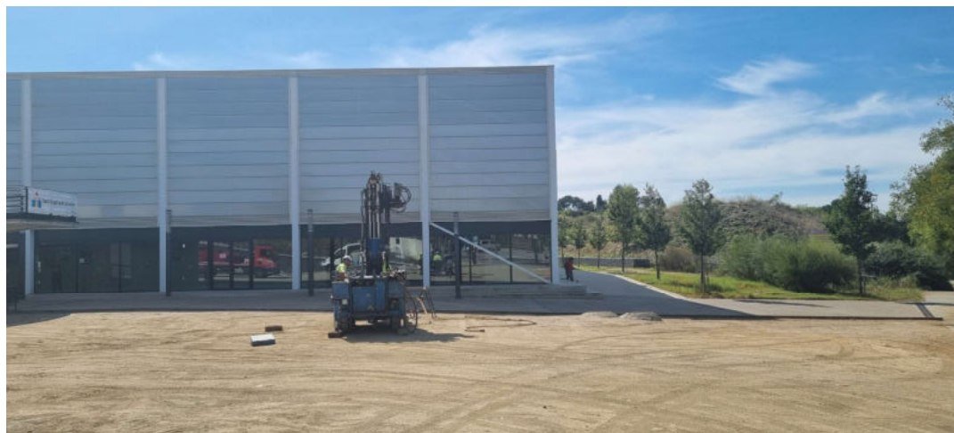
Vista del recinte on es projecta la coberta
