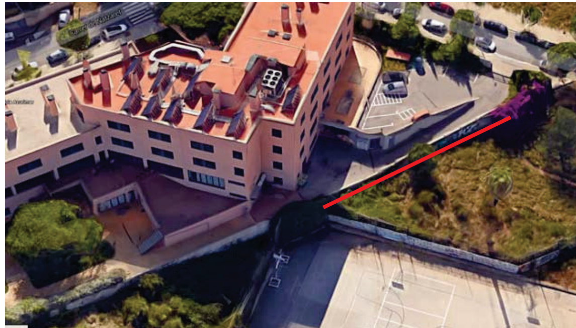
Situación pantalla de pilotes
