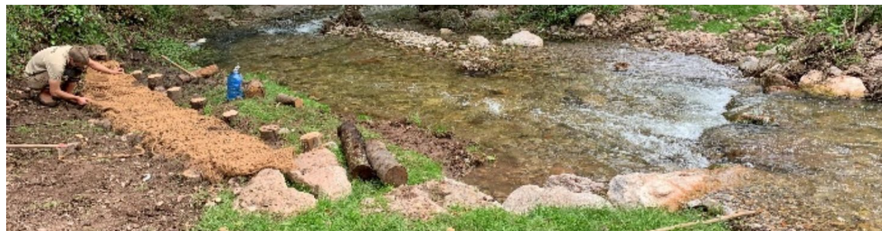
Figura 9. Exemple d'estructura J-vane executada al riu Ripoll.
