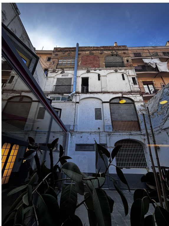
Façana pati Centre Sant Pere 1892
