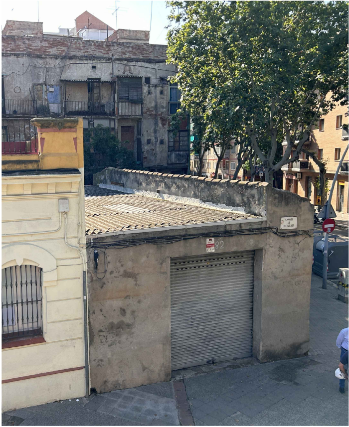
Entrada a la parcel·la des de C/ de Monlau
