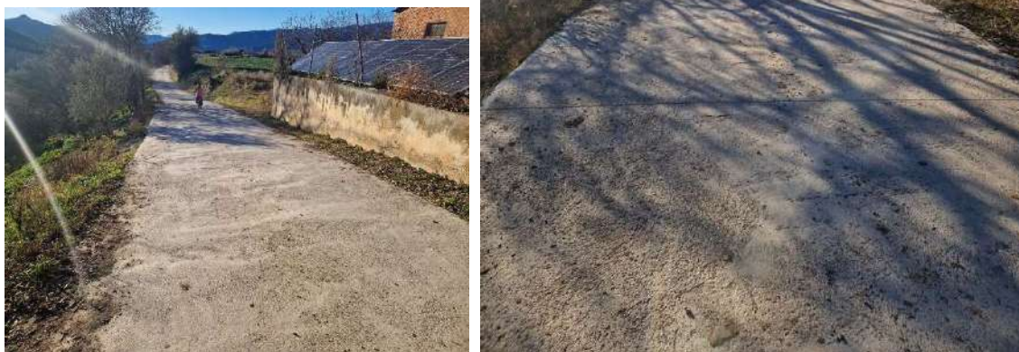
Imatge 3. Paviment de formigó on executar la rasa.
