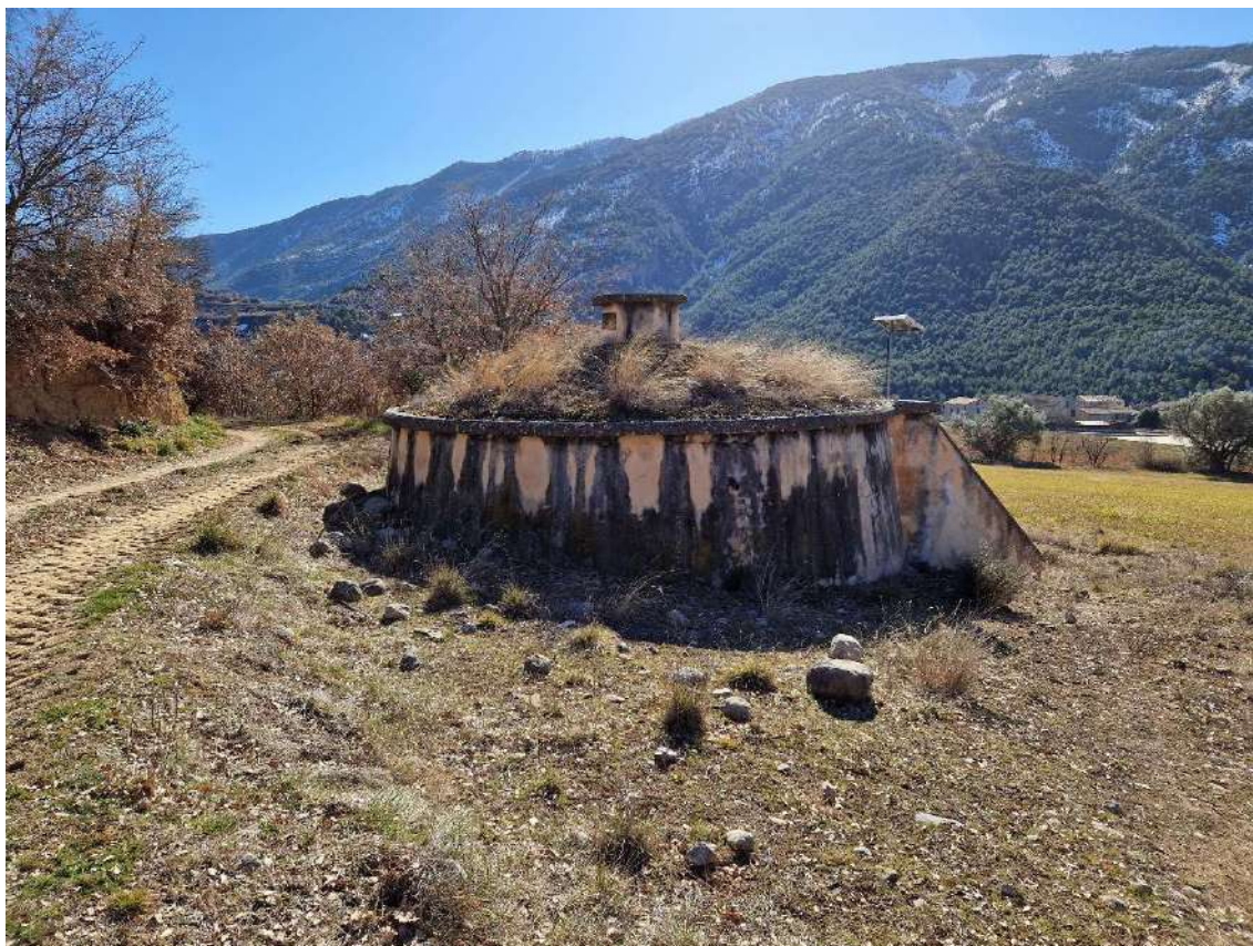
Imatge 4. Estat actual de dipòsit d'Aramunt
