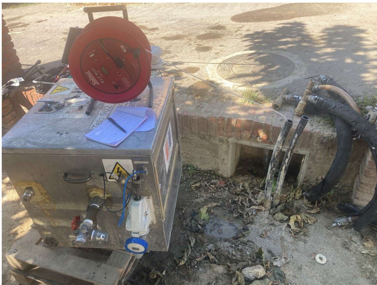
Fotografia 1: Detalls del Mòdul a l'obra, comprovant profunditat i temperatura inicial
