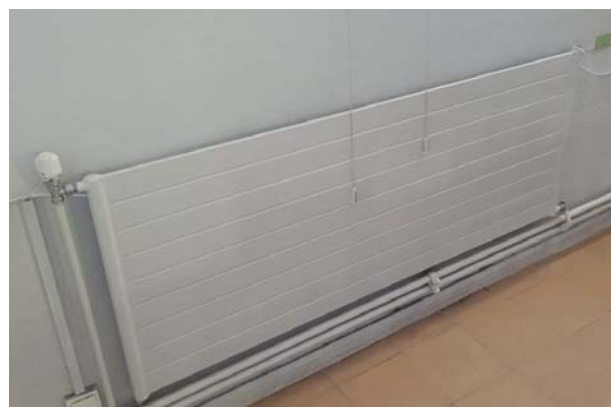
Imatge 3 i 4. Radiador de panells d'acer a interior aules (Font: Energi)
