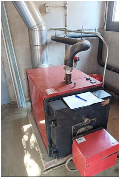
Imatge 1. Caldera de gasoil del CEIP (Font: Energi)
