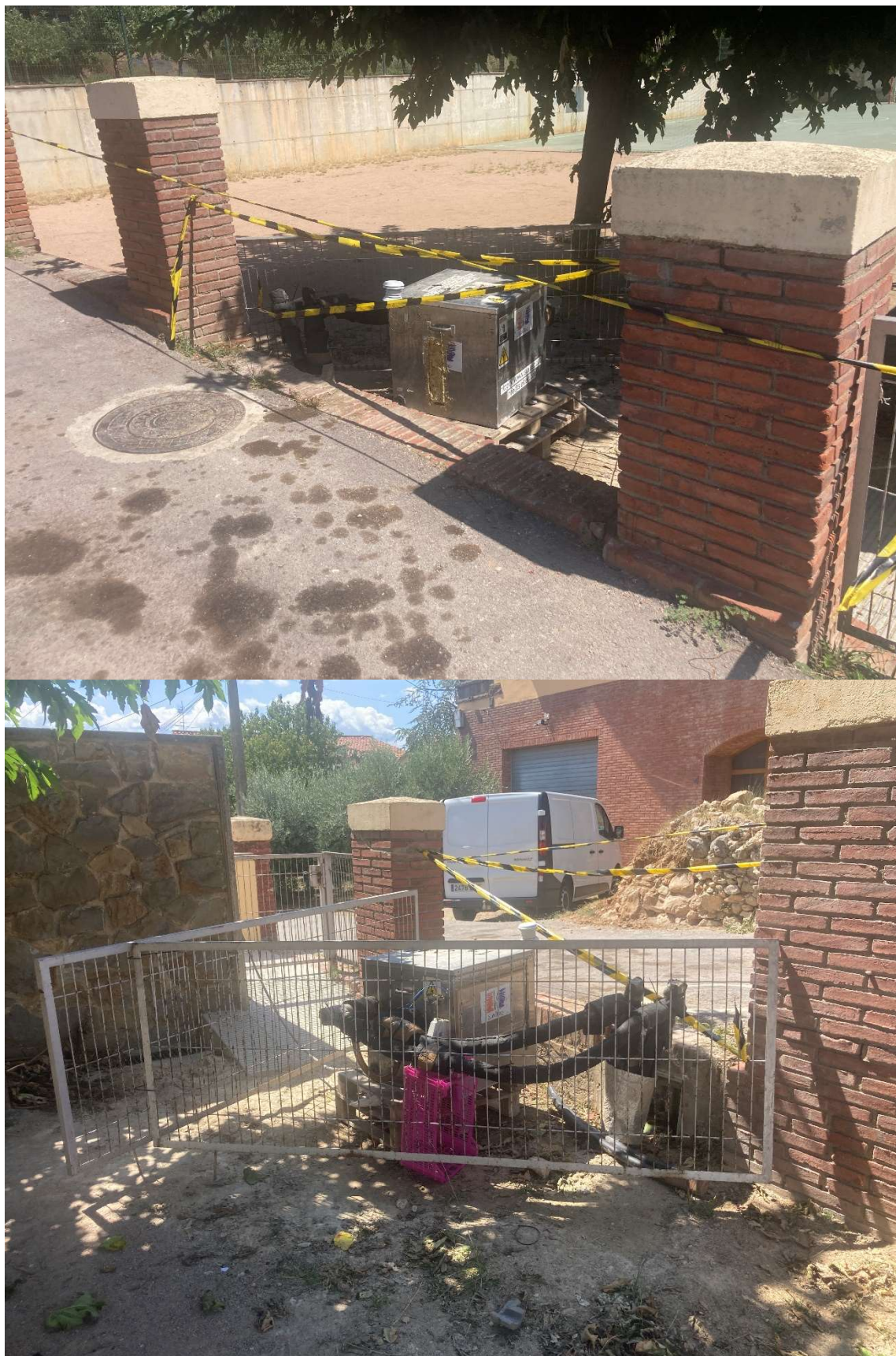
Fotografia 2: Detalls del Mòdul a l'obra
