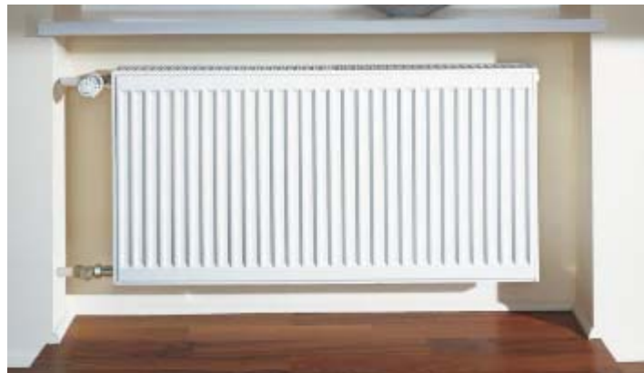
Imatge 6. Radiador de baixa temperatura projectat (Font. TECNA)
