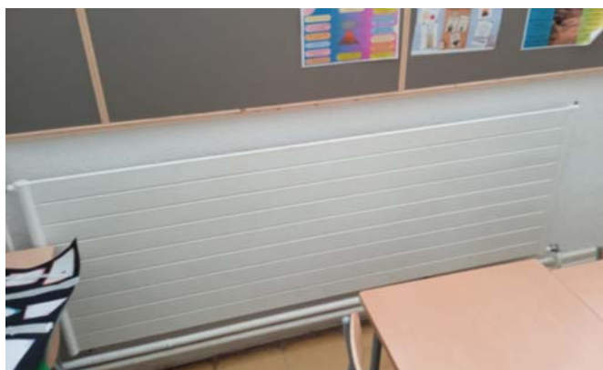
Imatge 3 i 4. Radiador de panells d'acer a interior aules (Font: Energi)
