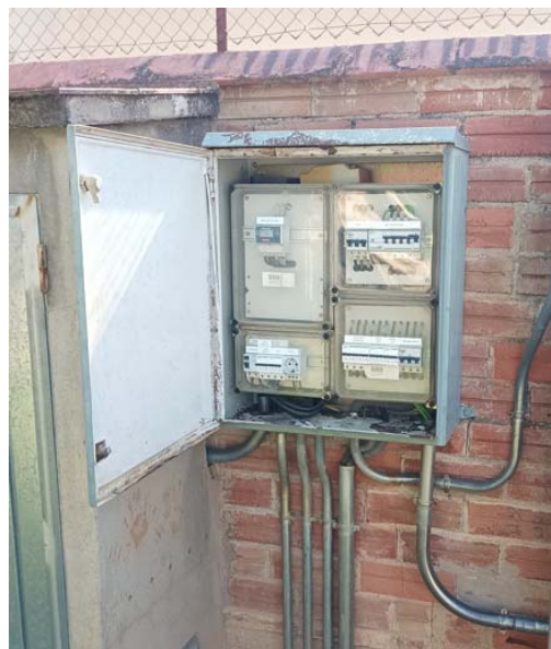
Imatge 5 i 6. Quadre principal CEIP i caseta autotransformador i inversor FV (Font. Energi)
