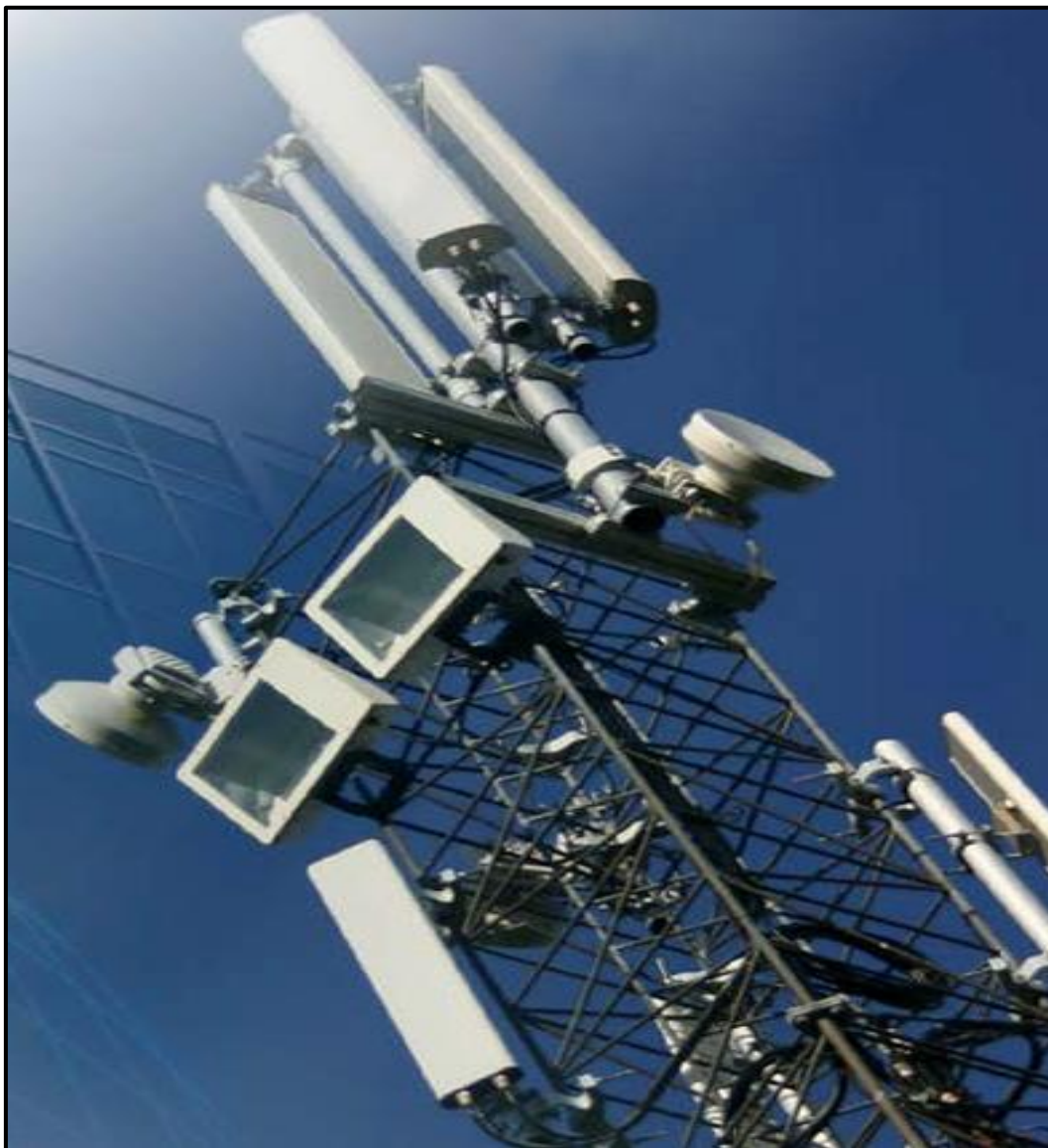
Imatge 16 Aspecte infraestructura de comunicació en FASE 1.
