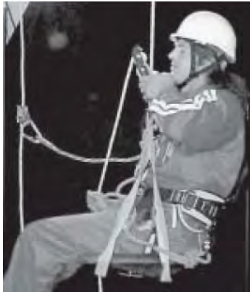
Figura 1 Descenso mediante descendedor autoblocante y dispositivo anticaídas
