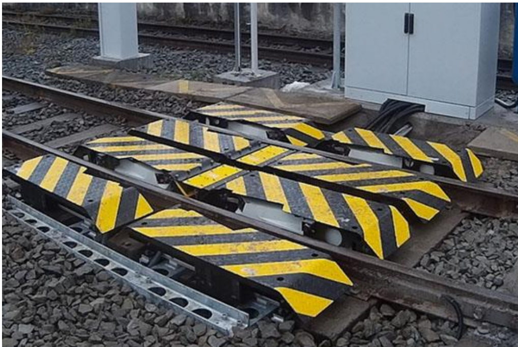
Foto: Equip mesura paràmetres rodes exterior
