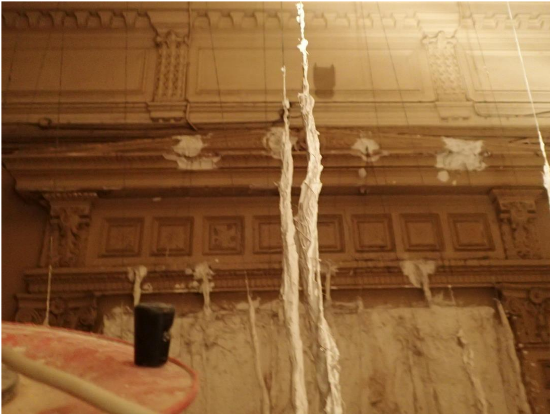
Planta Primera –Sala de contractacions- Part superior de la porta de fusta de la sala principal conservada sota sostre enderrocat
