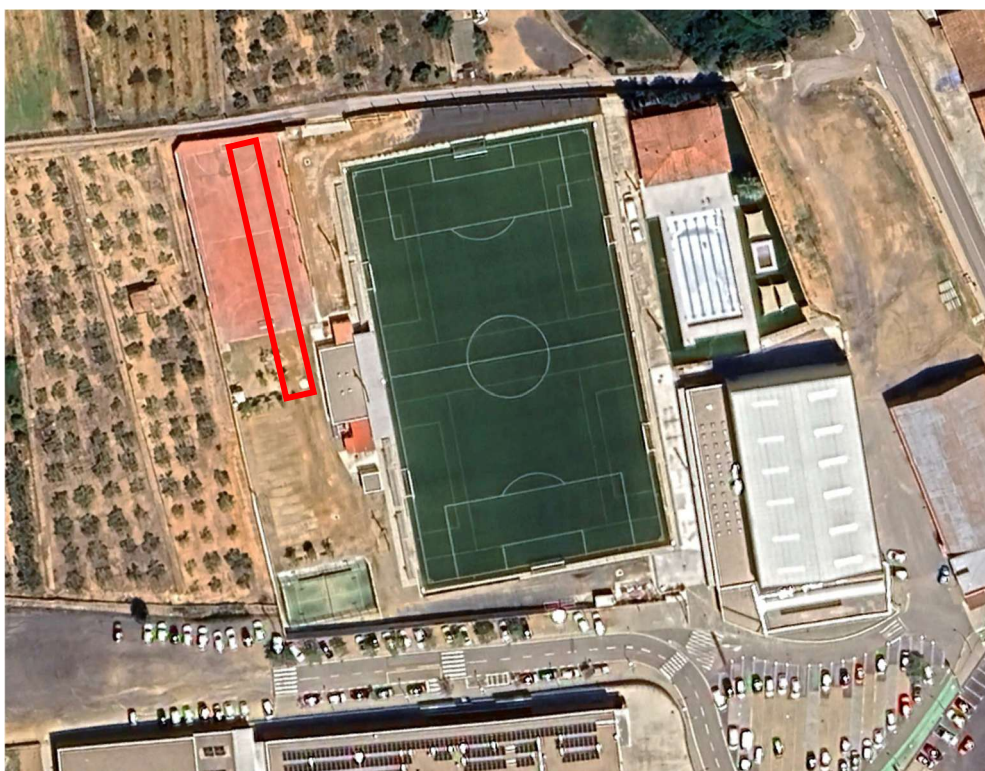
Zona nou mur
