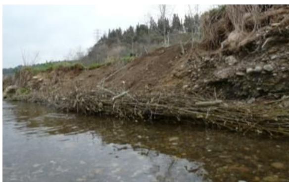
Feixina viva acabada d'instal·lar i feixina després d'uns 4 anys
