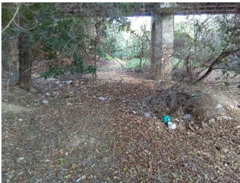
Estructura del pont del Carrer de les flors
