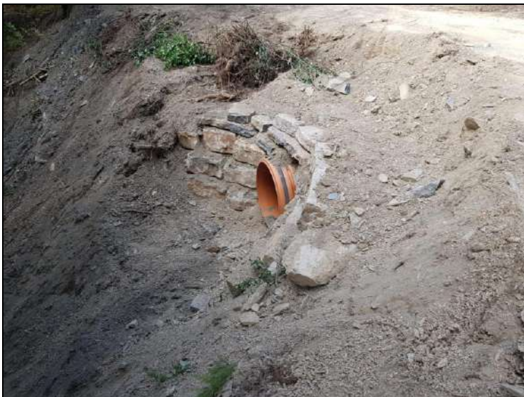
Imatge 12. Exemple d'escullera en sortida d'obra de drenatge
