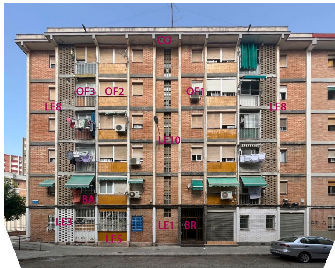
F1 Façana principal
