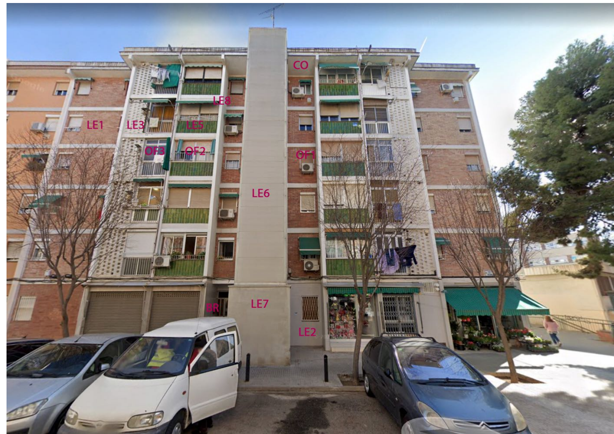
F1 Façana principal
