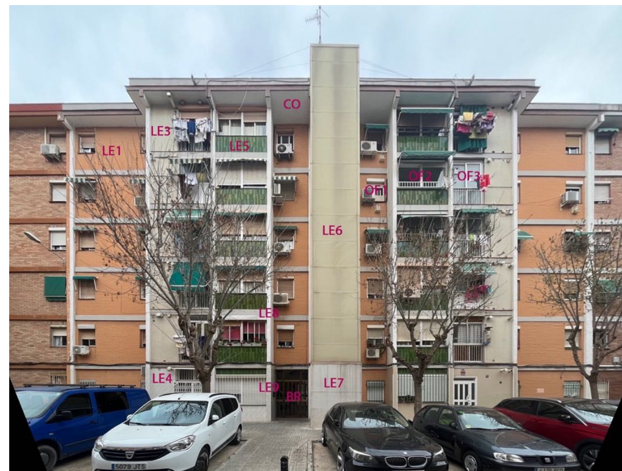
F1 Façana principal
