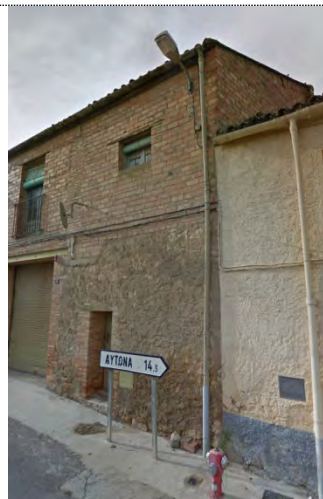
Lluminària Sobre Pal de Formigó LIF117
