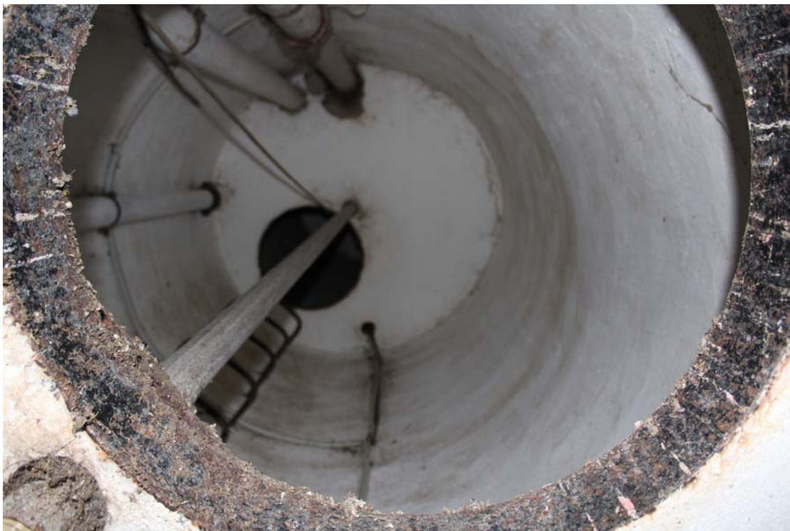
Vista zenital dels sostres dels replans del dipòsit i de l'escala de gat.
