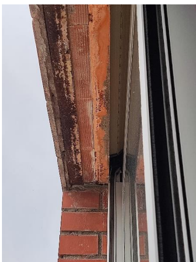
Imatge 7: Llinda amb perfils d'acer rovellats
