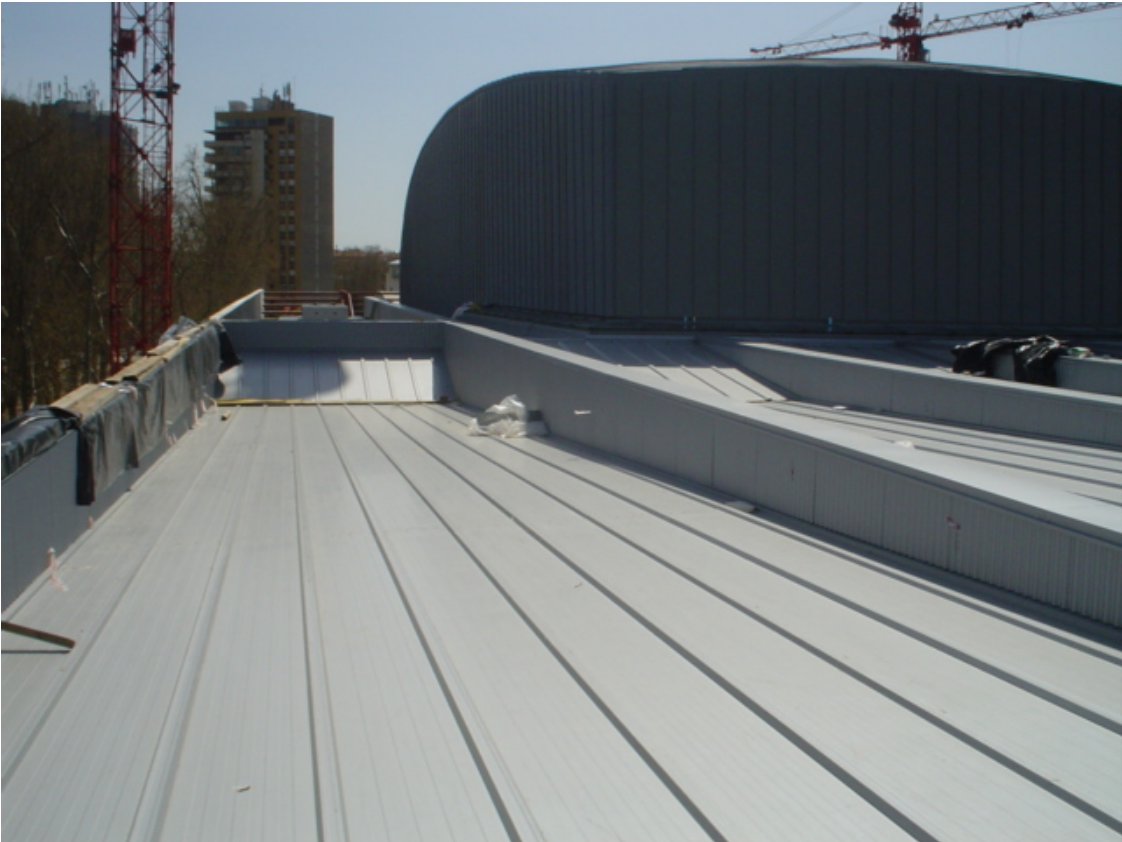
Imatge de la coberta de la zona 2
