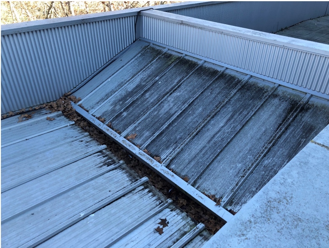
Neteja de canaló i col·locació de goteró al final del nou revestiment de la part esquerra.
