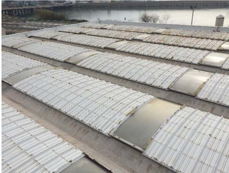
Imatges de la coberta de l'edifici de deshidratació.
