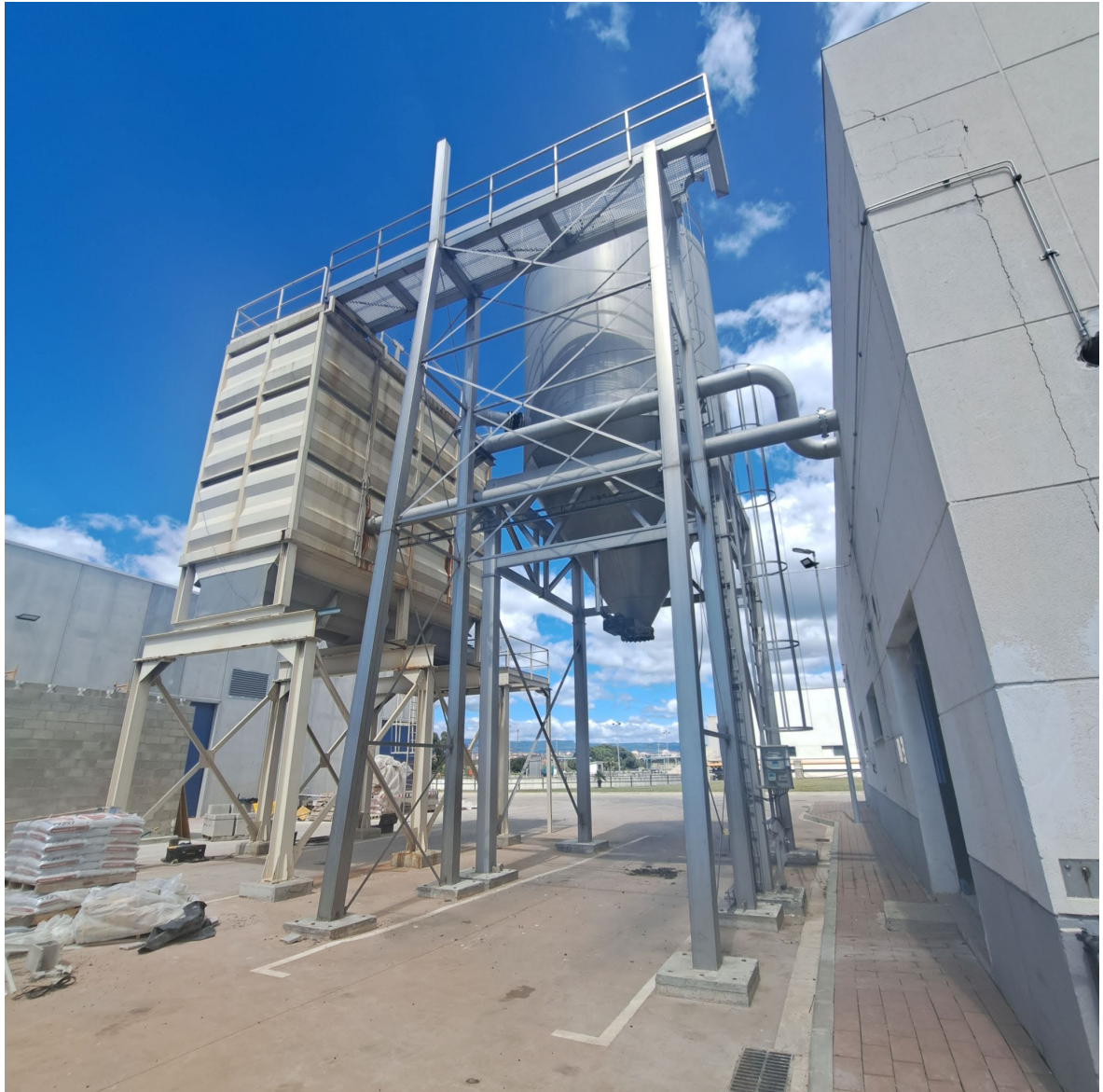
Foto Núm 3: Vista estructura a substituir per una passarel·la d'accés
