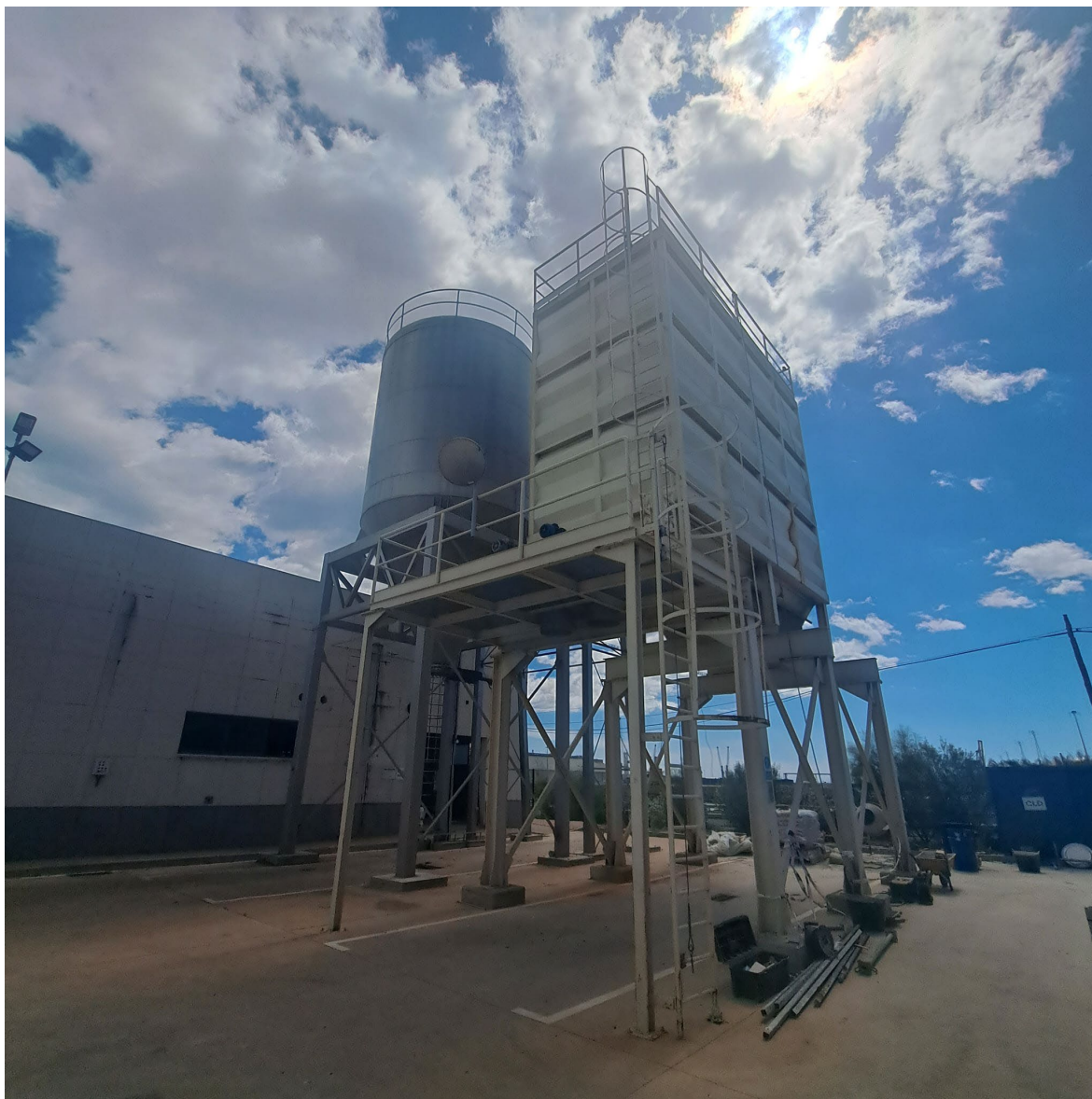
Foto Núm 1: Vista de la sitja a substituir. Secció rectangular
