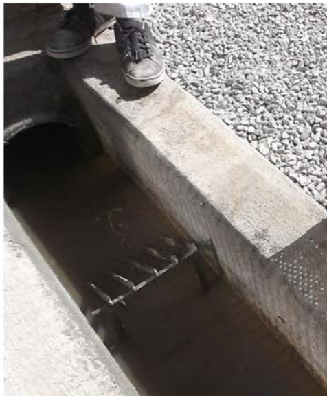
Canal acabat amb la reixa de gruixuts
