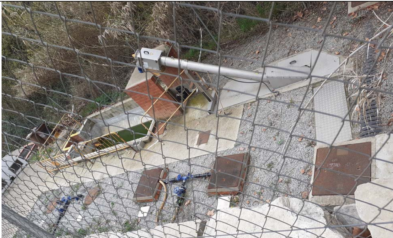
Foto 6. .Vista general de tota l'EDAR
