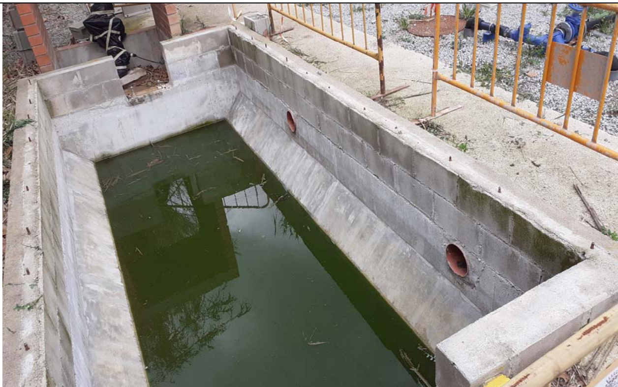
Foto 3. Reactor biològic sense els biodiscs
