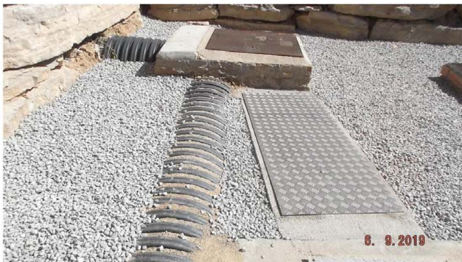
Canal de pretractament tapat amb xapa antilliscant
