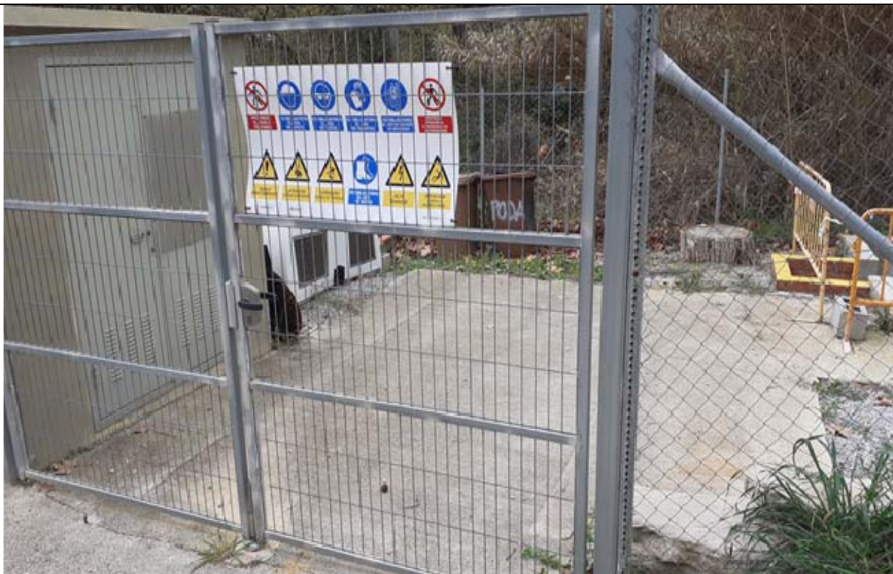
Foto 7. .Entrada a l'EDAR
