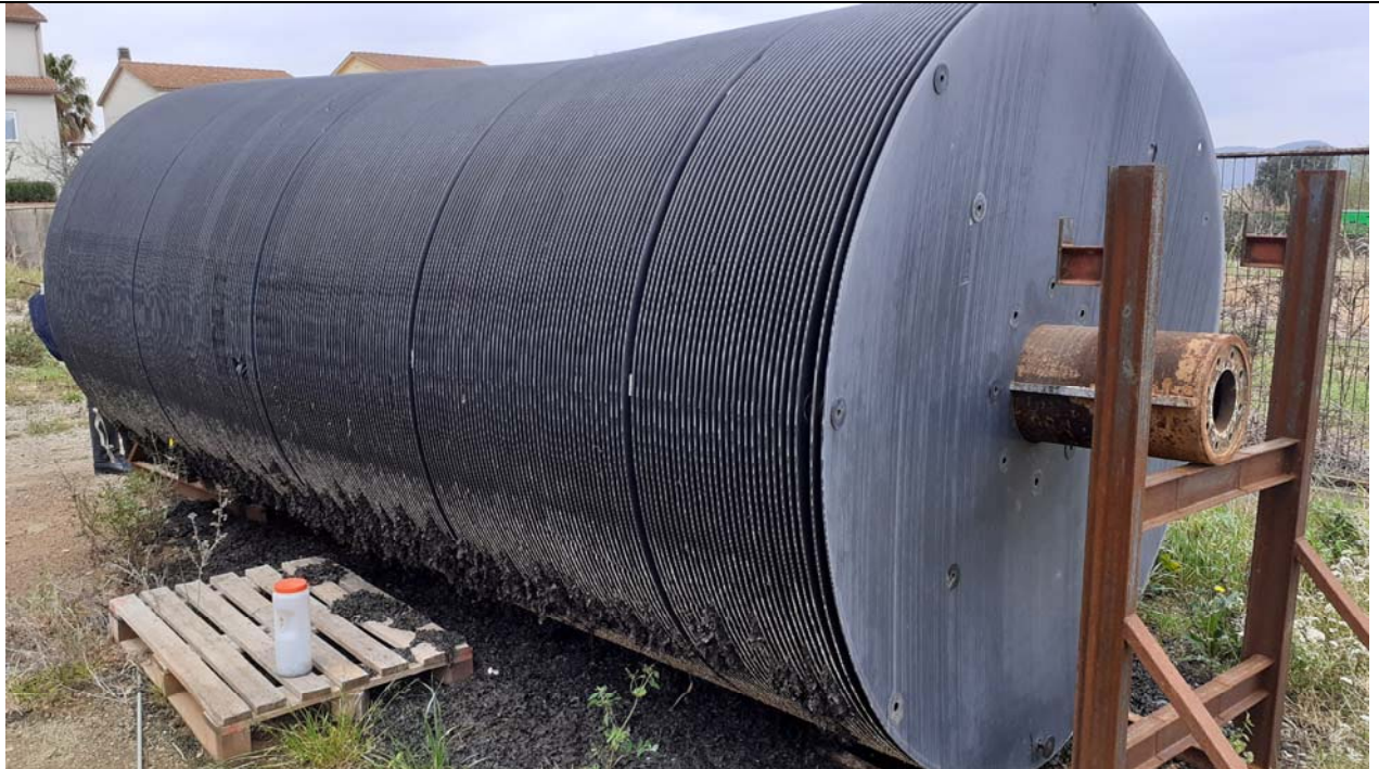
Foto 4. Biodiscs malmesos acopiats fora del reactor biològic
