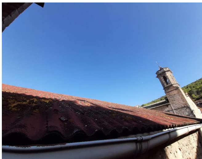
8. Vista general de la vessant Oest de la coberta.
