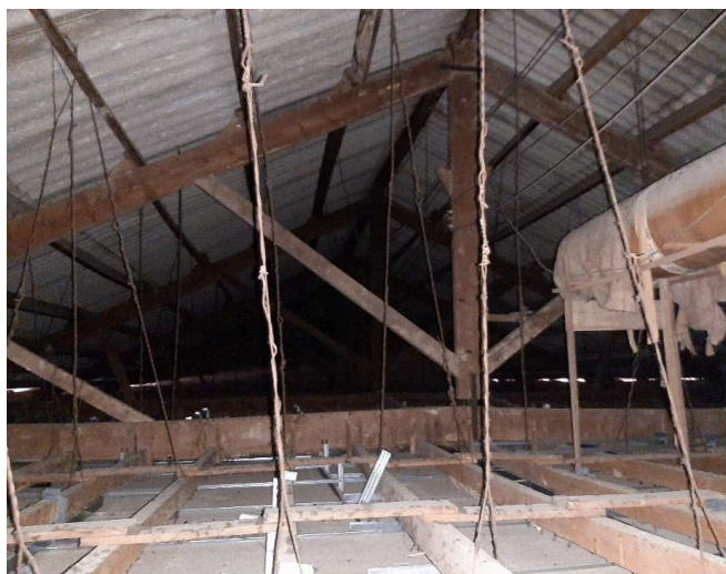
1.Vista general de l'encavallada de fusta.
