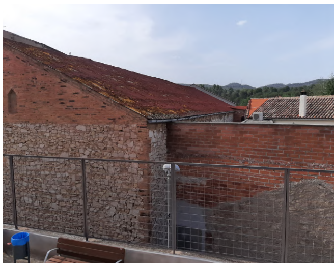
7. Vista general exterior de la vessant Est de la coberta.
