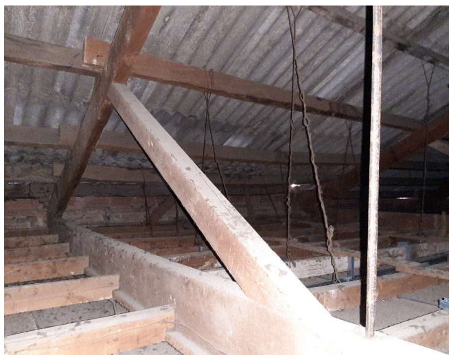
5.Vista general de la trobada entre les corretges de fusta i l'encavallada.
