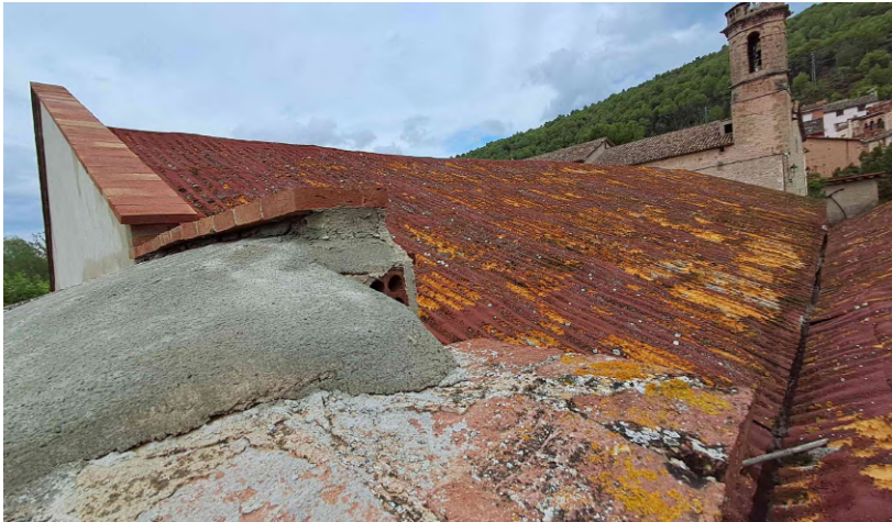
11. Detall de coberta des de la part superior de la façana principal, a nord.
