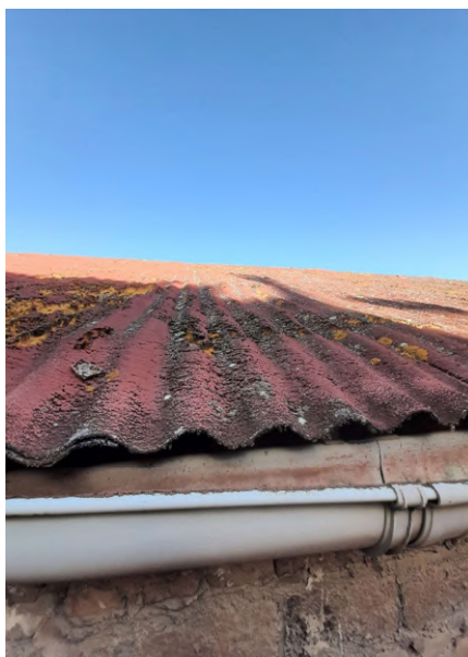
9. Detall vessant Oest de la coberta.
