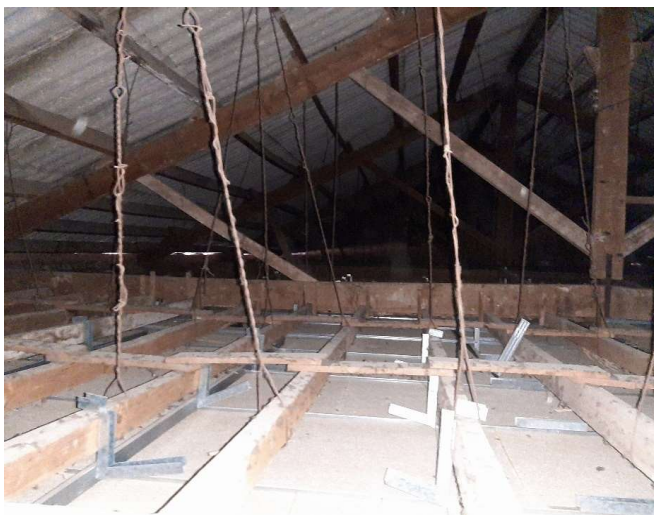
2.Vista general de l'encavallada de fusta.
