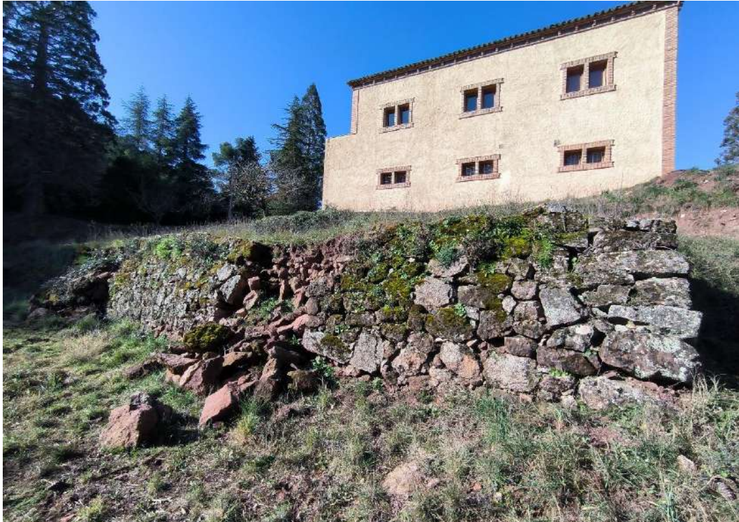
I13. Marge C-3, vist des de la part inferior. L'edificació que es veu és el magatzem de la brigada forestal del PNIN. Març 2025. Imatge Rosa Garrell.
