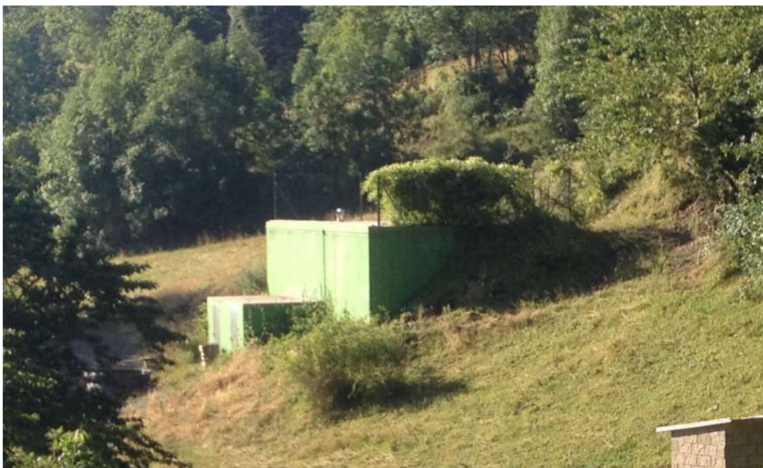
Vista general dipòsit d'Argolell
