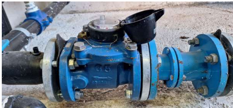
Foto 3: Detall comptador Woltman existent DN65mm.
