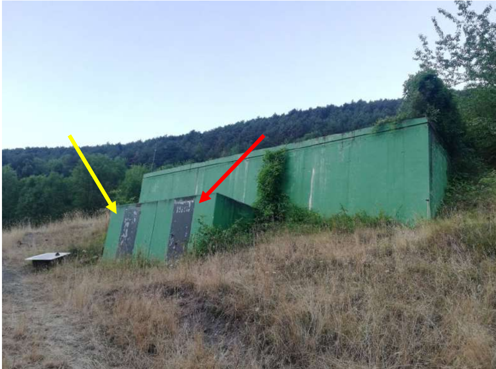
Foto 1: Vista general dipòsit nou d'Argolell. Fletxa vermella caseta de valvuleria de sortida d'aigua a la xarxa de distribució on s'instal·larà l'equip de desinfecció d'UV. Fletxa groga és la caseta de les actuals instal·lacions de desinfecció amb hipoclorit sòdic, que estan fora de servei
