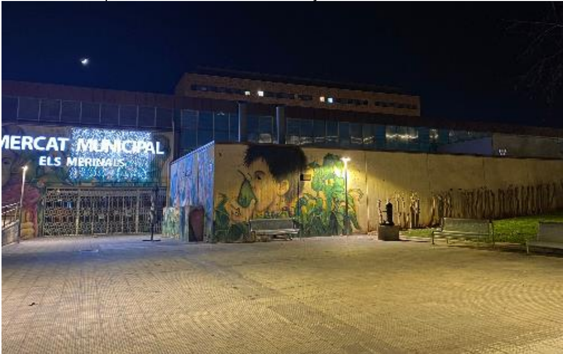
Exemple d'instal·lació lumínica a la façana del Mercat Els Merinals
