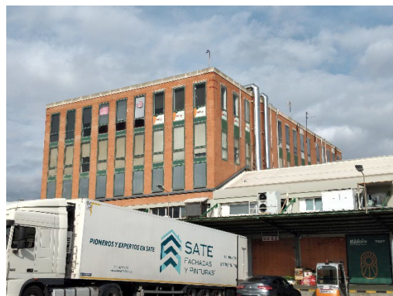
Vista del lateral i part de la façana posterior de l'edifici d'oficines del pavelló G
