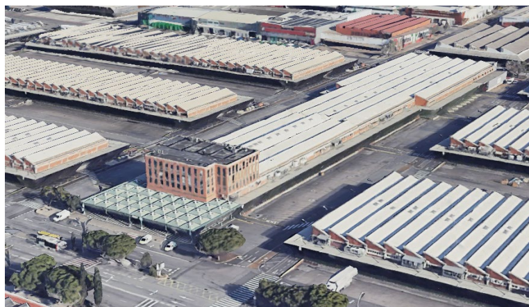
Vista general de l'edifici d'oficines i el pavelló G
