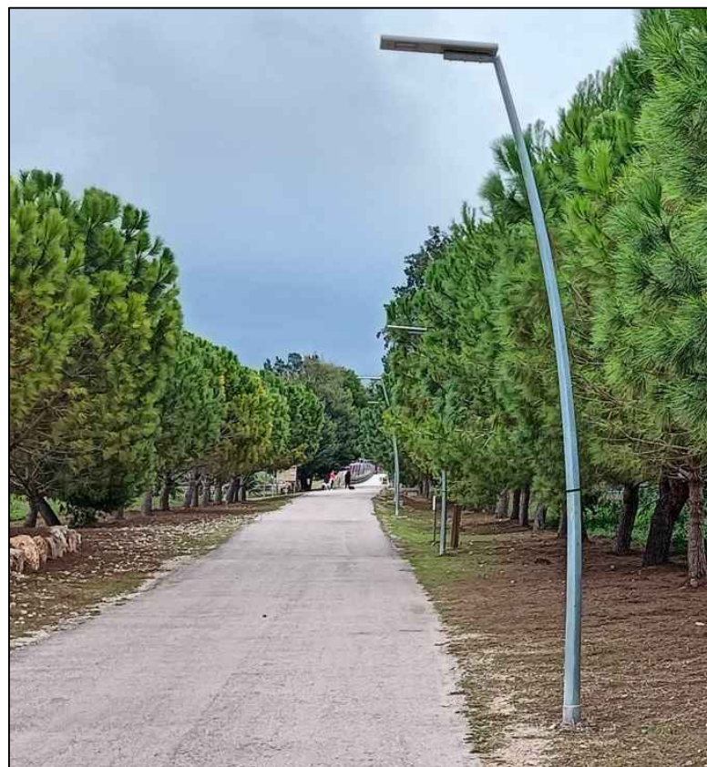
ESTAT ACTUAL DE LA VIA VERDA AMB L'ENLLUMENAT ALL-IN-ONE OBSOLET
