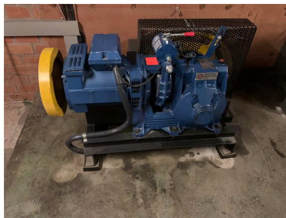
Detall dels grups tractors amb reductors actuals
