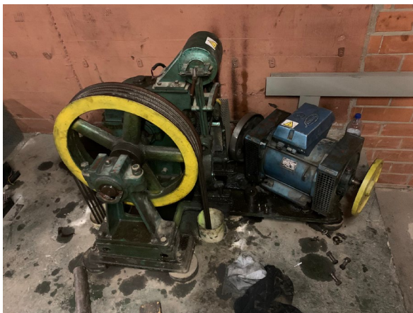
Detall dels grups tractors amb reductors actuals
