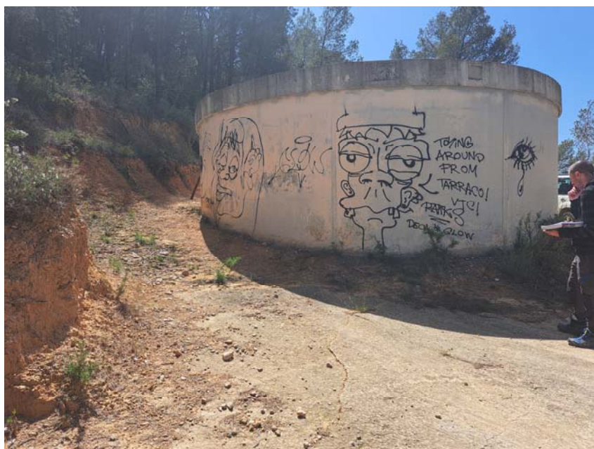
9. Sistema Aiguamúrcia. Dipòsit d'Aiguamúrcia. Dipòsit de distribució. Espai disponible per ubicació de caseta de tractament i caseta d'instal·lacions fotovoltaiques.
