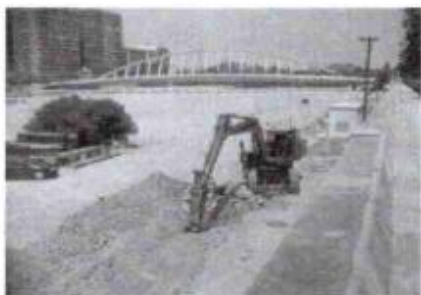
DEMOLICIÓN MECÁNICA A CIELO ABIERTO
